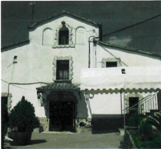
Façana principal de la masia
