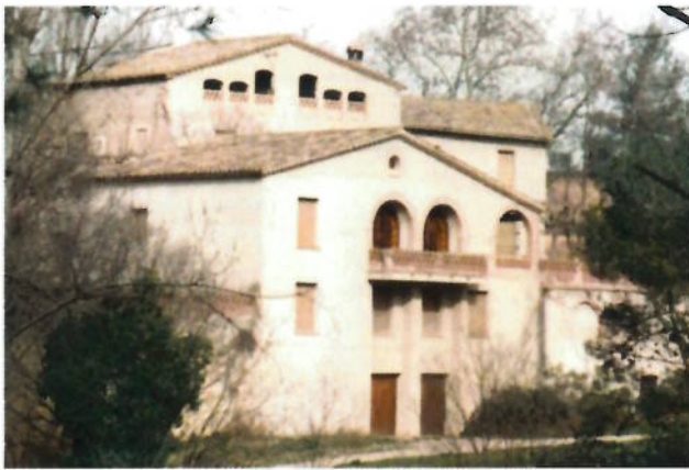
Vista del conjunt de Can Xercavins des del sud
