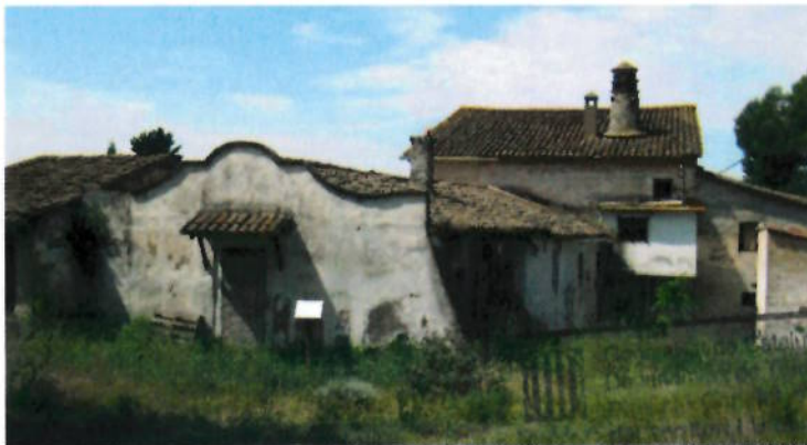
Vista del conjunt
