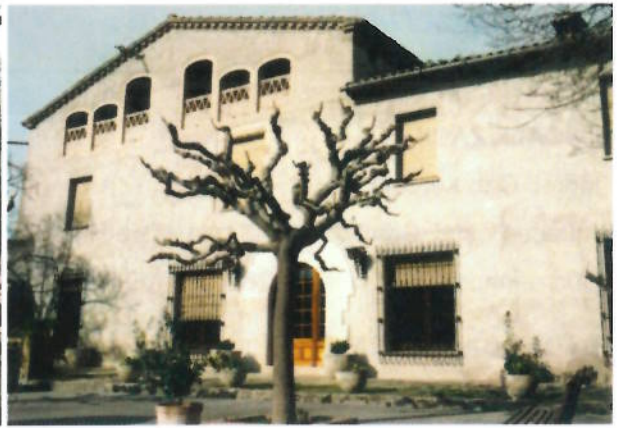
Façana sud de la masia
