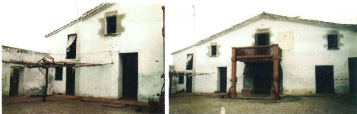
Façana principal de la masia
