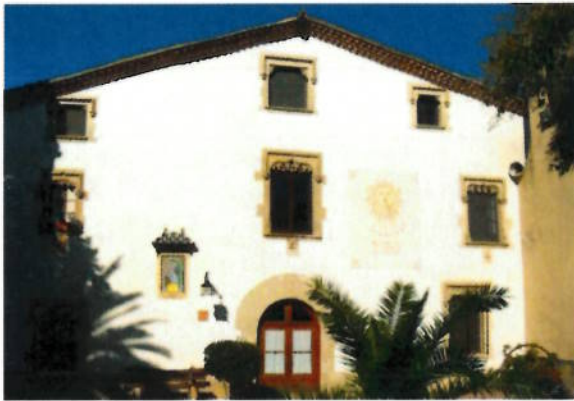
Façana principal de la masia
