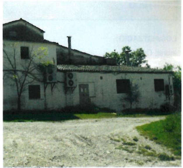
Façana posterior amb els annexes adossats a la masia
