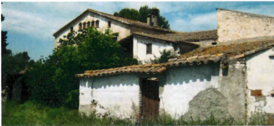
Vista del conjunt
