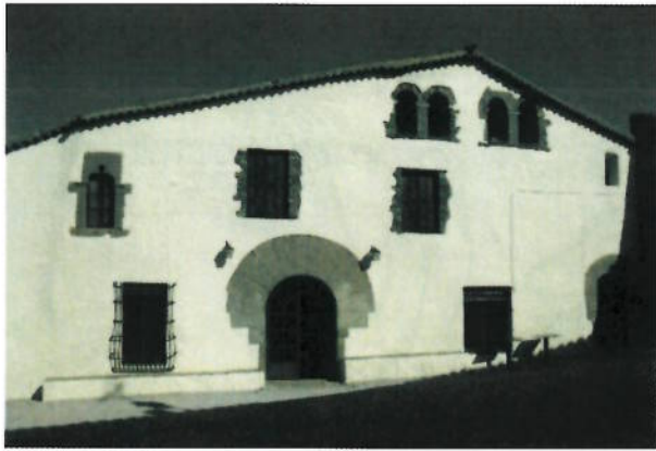
Façana principal de la masia
