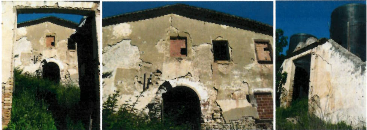
Façana principal de la masia i porxada d'accés
