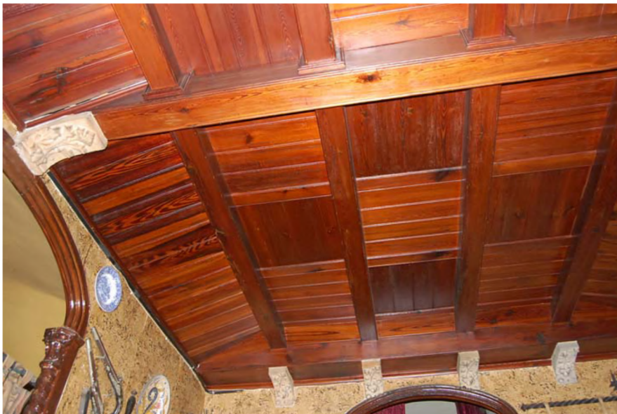
72. Cassetonat de fusta a la sala de la planta baixa
