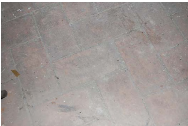
70. Paviment de la planta sotacoberta
