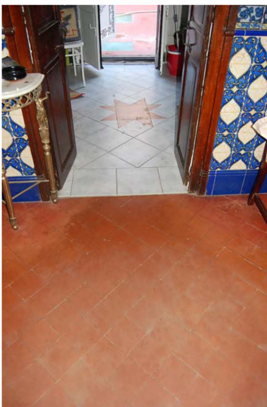
69. Paviment de la planta primera i paviment bany (sobreposat)
