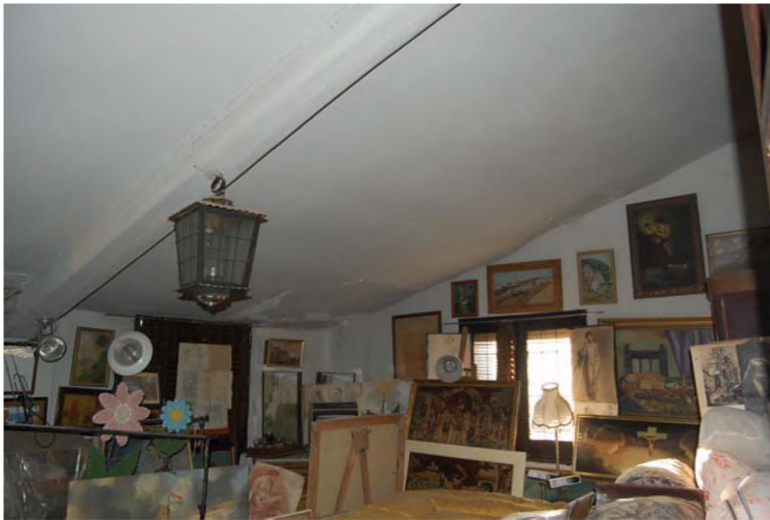
54. Habitació sota coberta (cel ras sobreposat)
