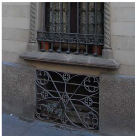
11. Ventilació del soterrani
