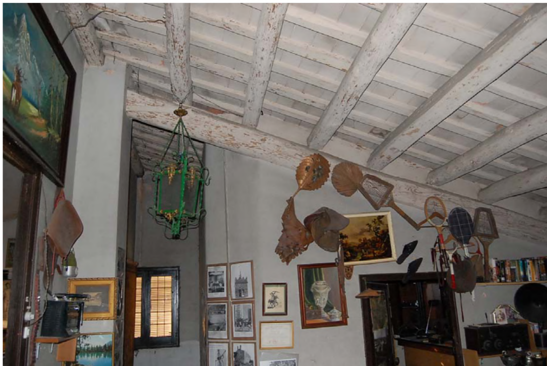
51. Sostre original sota la coberta
