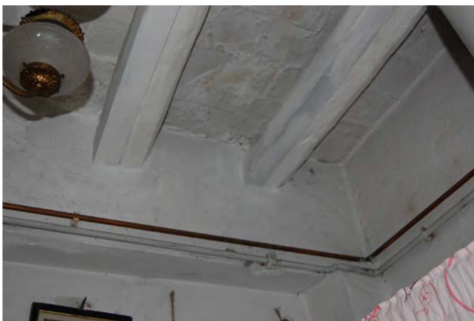
75. Sostre del rebost a la planta baixa
