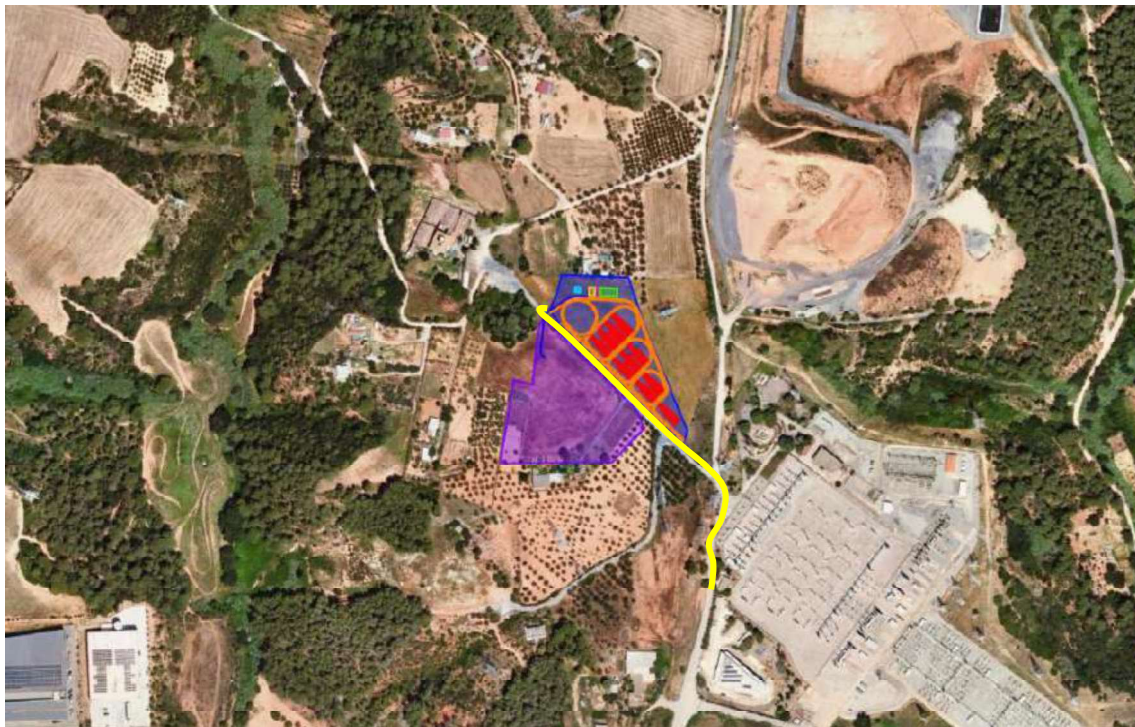
Figura núm. 1. Accés a la parcel·la de la planta de bateries FRV Rubí.
