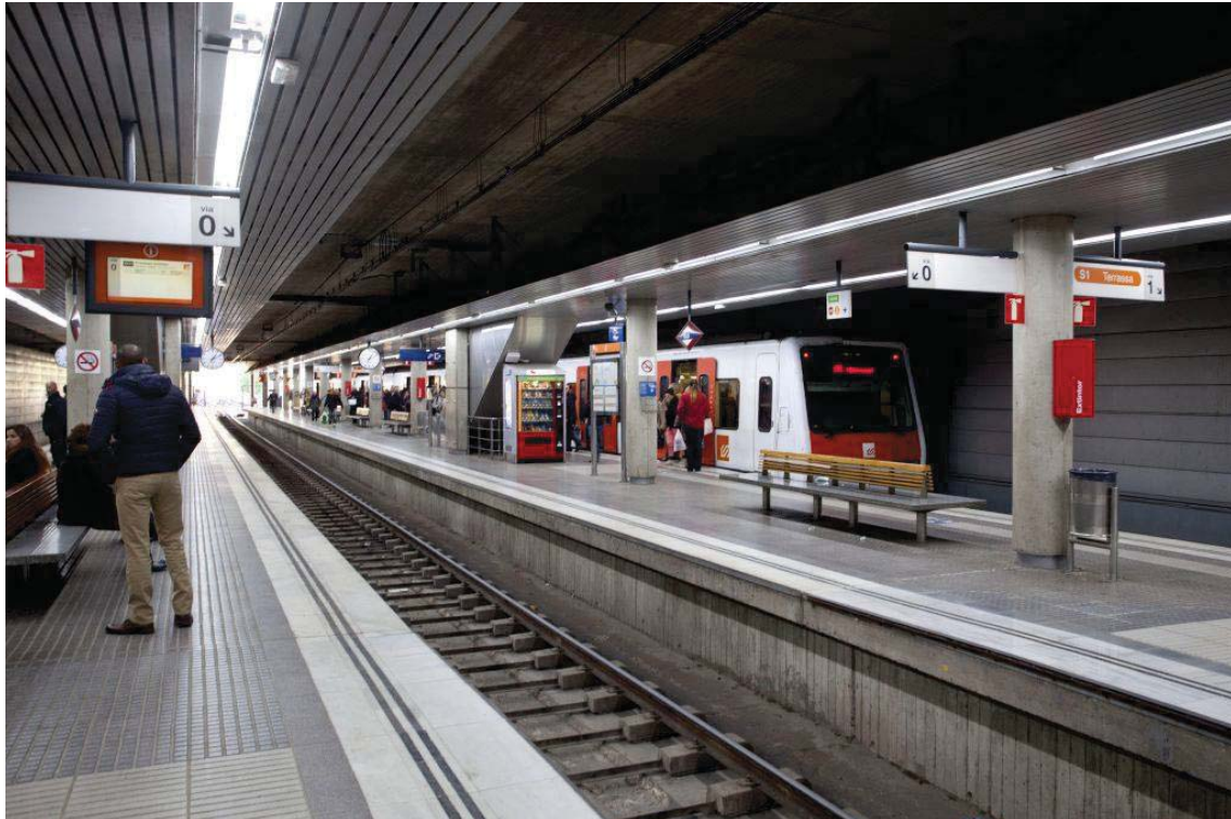
Figura 3.12. Andanes de l'estació Rubí Centre
