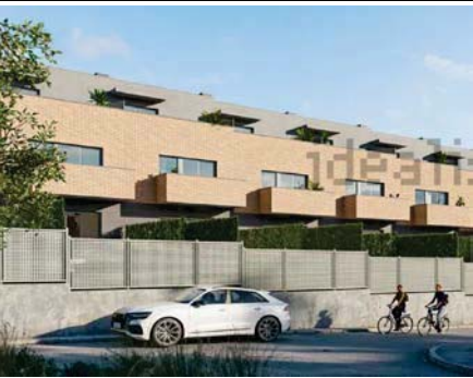
Districte Est Carrer d'Hipatia, sn Nombre de testimonis: 10 2.984,83 €/m 2 construït
