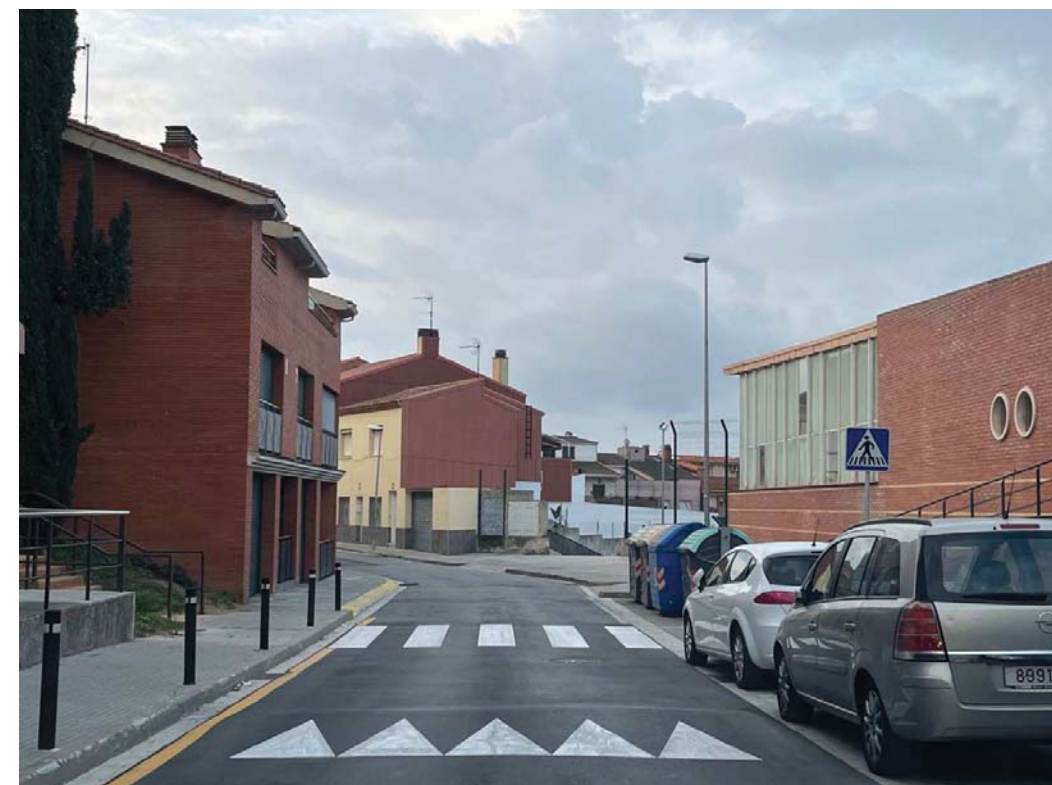
Pas de vianants elevat al carrer Zamora. Font: Elaboració pròpia
