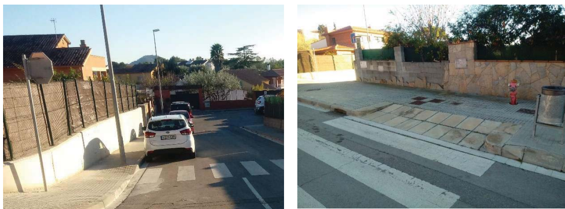
Figura 4.2. Gual de vianants no adaptat a la cruïlla entre el carrers Aneto i passatge de les Pereres (esquerra), i pas adaptat a la intersecció entre els carrers Antic de Can Ximelis i Presseguers
