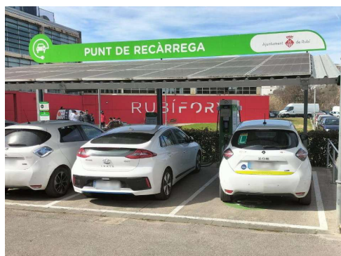
Punt de recàrrega de vehicles elèctrics (INTRA)
