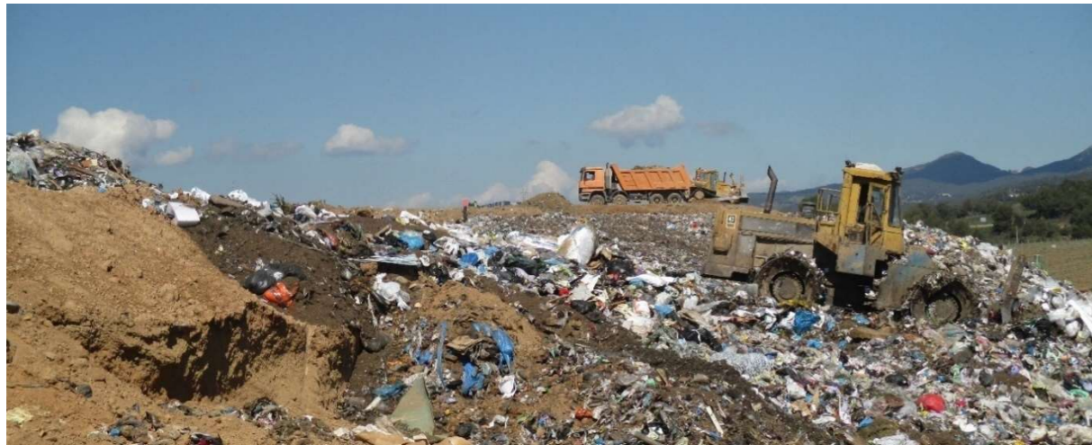
Compactació de residus i cobriment simultani amb terres al fons
