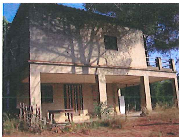
Façana inferior de la segona edificació aïllada .
