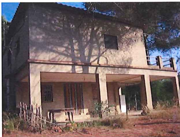
Façana inferior de la segona edificació aïllada .
