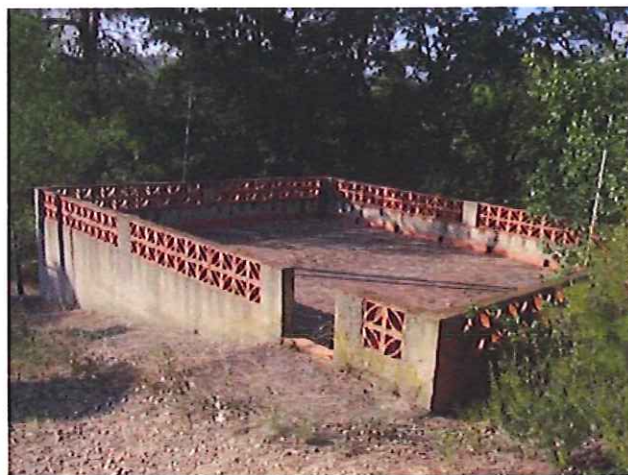
Una de les dues edificacions aïllades que formen un sol conjunt, situada en una fondalada en el quadrant NE del sector.
