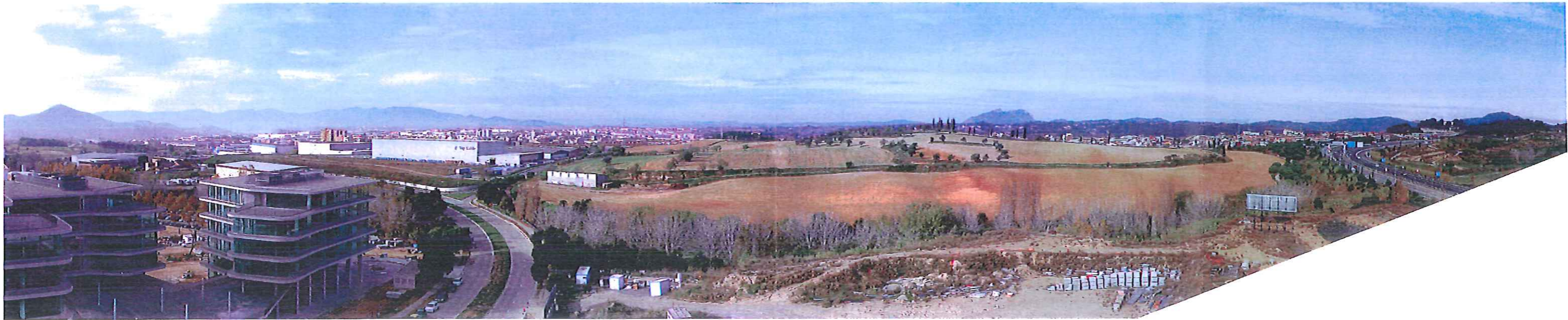
01 IMATGE AÈREA EDIFICIS ENTORN POLÍGON CAN SANT JOAN
