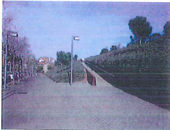
29 AVINGUDA DE L'ESTATUT - ACCÉS PARC CA N'ORIOI VIAL DE CONNEXIÓ A SECTOR Z NO DESENVOLUPAT
