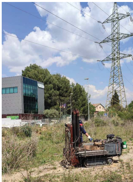
Figura 3. Execució del penetròmetre P-2
