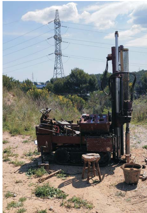
Fotografia 4. Execució del sondeig S-1R.
