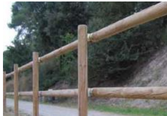
Figura núm. 7. Barana de fusta tipus Tejana de Rivisa o equivalent.
