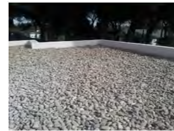
Coberta plana amb acabat de grava
