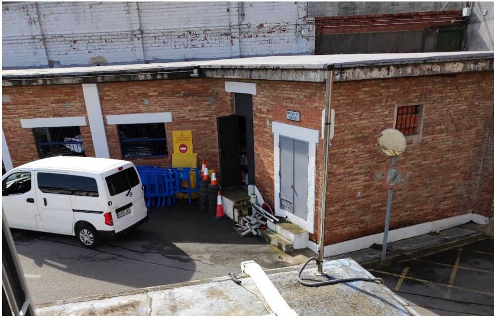
Il·lustració 9: façana oest de l'edifici on es preveu ubicar la nova TMF-10, i mur i coberta per on es preveu transportar el cablejat de l'extrem de la rasa fins a la sala on es preveu ubicar la nova TMF-10.
