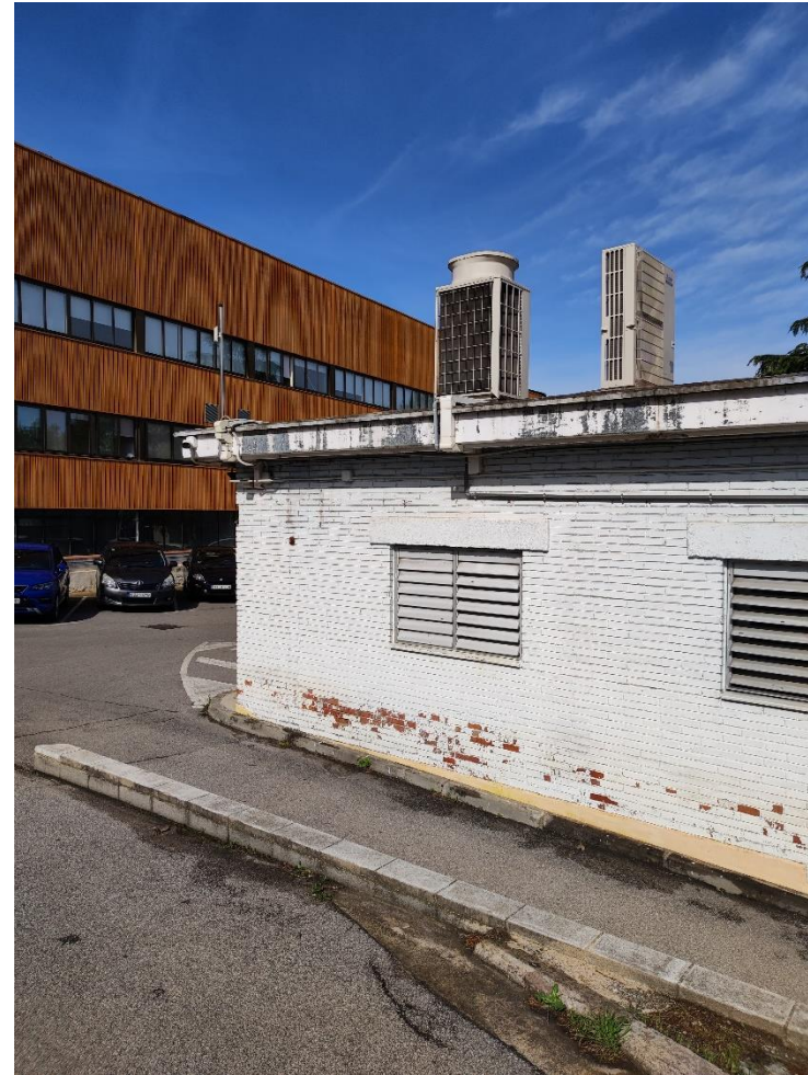
Il·lustració 8: façana sud-est de l'edifici principal del recinte, equips de climatització de coberta, i zona per on es preveu fer passar el cablejat de CA fins la rasa que farà arribar el cablejat fins l'edifici on es preveu ubicar la nova TMF-10.
