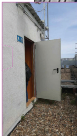
Zona d'accés a la coberta i on es preveu la instal·lació interior de l'inversor
