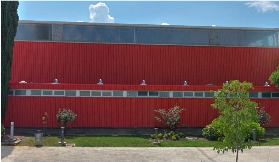
Il·lustració 1: vista frontal de l'edifici, a la primera zona de la coberta, zona prevista per a la ubicació de l'inversor.
