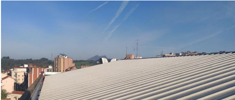
Il·lustració 1: superfície solar 1. Coberta sud de l'edifici, amb vistes cap a l'oest.
