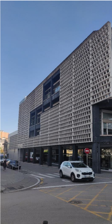
Il·lustració 5: vista emplaçament. Carrer Aribau.
