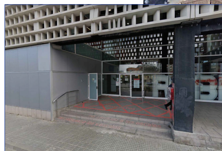
Accés principal a l'edifici i zona de pujada de material a la coberta a través de camió ploma (o equivalent)
