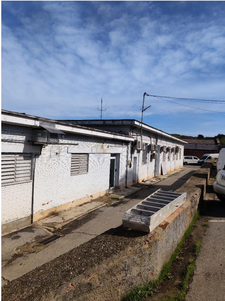
Il·lustració 7: façana est de l'edifici principal del recinte. A la zona de teulada, a la superfície inferior propera al mur generat per la diferencia d'alçada de la teulada, zona prevista per a la ubicació de l'inversor dins armari.
