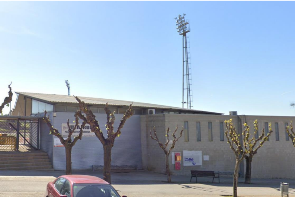
Il·lustració 1: coberta de la zona oest, on es preveu la instal·lació dels panells fotovoltaics.
