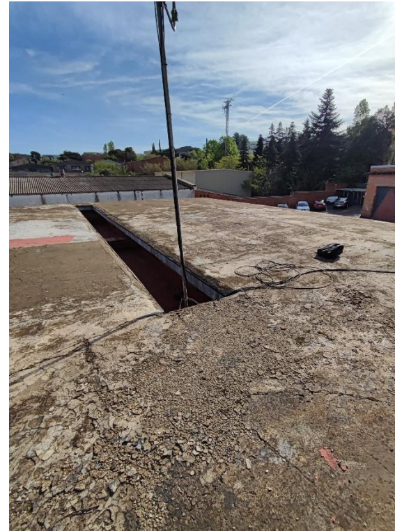
Il·lustració 2: coberta amb vistes cap a la zona Nord.
