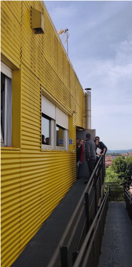
Il·lustració 3: rampa d'accés a la zona del pis superior de l'edifici. Per la partint interiors, sala on es preveu la instal·lació de l'inversor, dins armari de protecció.
