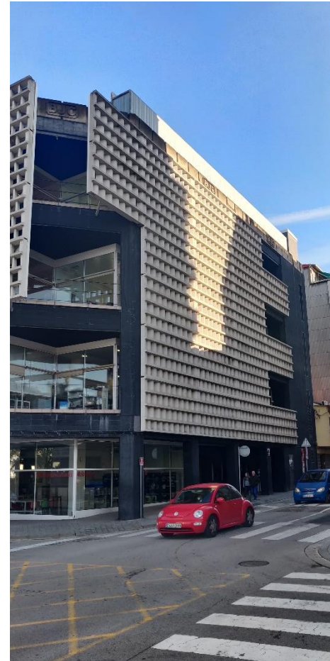
Il·lustració 4: vista de l'edifici. Carrer de Calderón de la Barca. Zona on queda ubicat el quadre elèctric de l'edifici.
