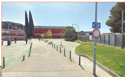
Zona d'accés al recinte
