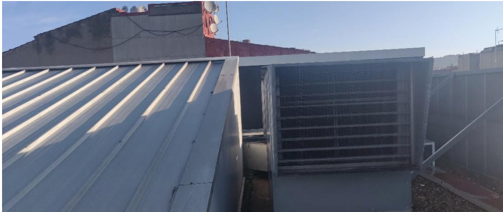
Il·lustració 3: Zona nord-est de la coberta. Zona on es troba l'accés a la coberta des de l'edifici, dins la qual es preveu instal·lar l'inversor. En aquesta zona nord-est de la coberta també es preveu fer transcórrer el cablejat de CA, des del quadre elèctric existent, ubicat en aquesta zona de la coberta, fins a la planta baixa de l'edifici, on es preveu la interconnexió de la instal·lació fotovoltaica amb la xarxa interior de l'edifici, a la zona del quadre general.
