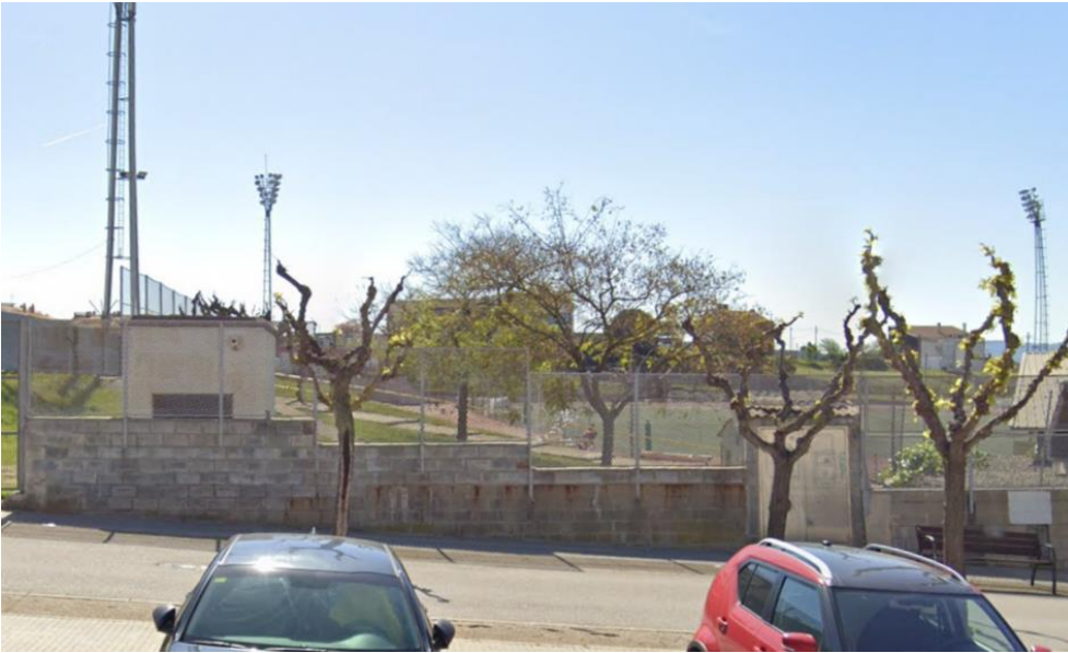
Il·lustració 5: zona del quadre general de la instal·lació, on es troba actualment l'ubicació dels comptadors de companyia.
