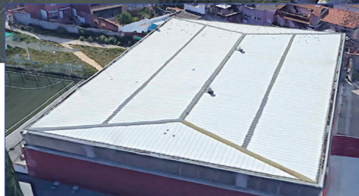
Superfície solar, on es preveu la zona d'acopi de material
