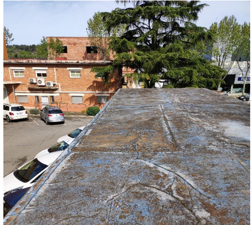
Il·lustració 6: vista de la zona sud-oest de la coberta.
