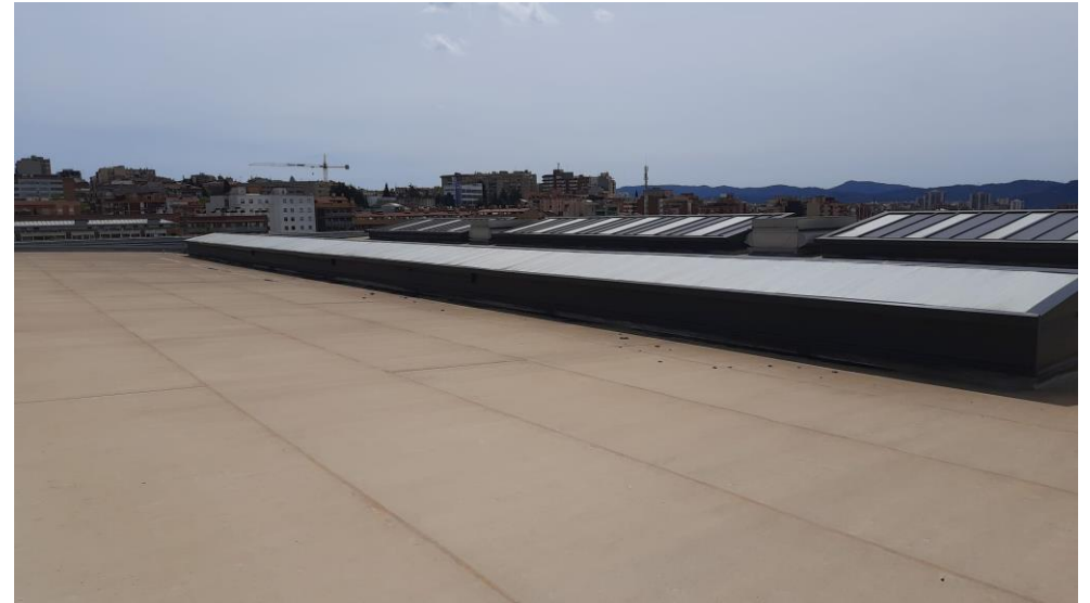
Il·lustració 2: vista de la banda sud de la coberta.
