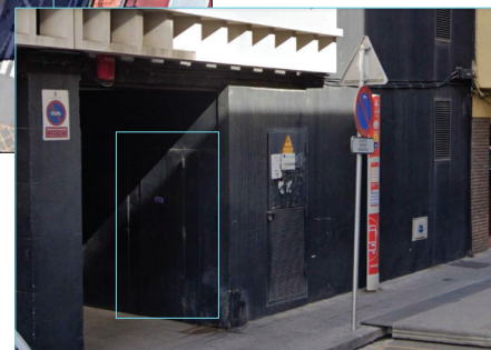
Zona del quadre general de la Biblioteca, on es preveu dur a terme la connexió a la xarxa interior de l'edifici
