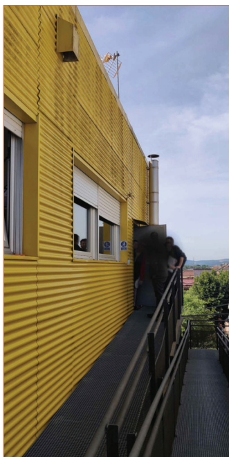
Zona d'accés a la coberta i ubicació prevista de l'escala de gat, per a l'accés de personal a la coberta
