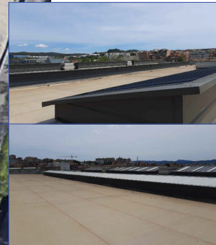
Superfície solar, on es preveu la zona d'acopi de material
