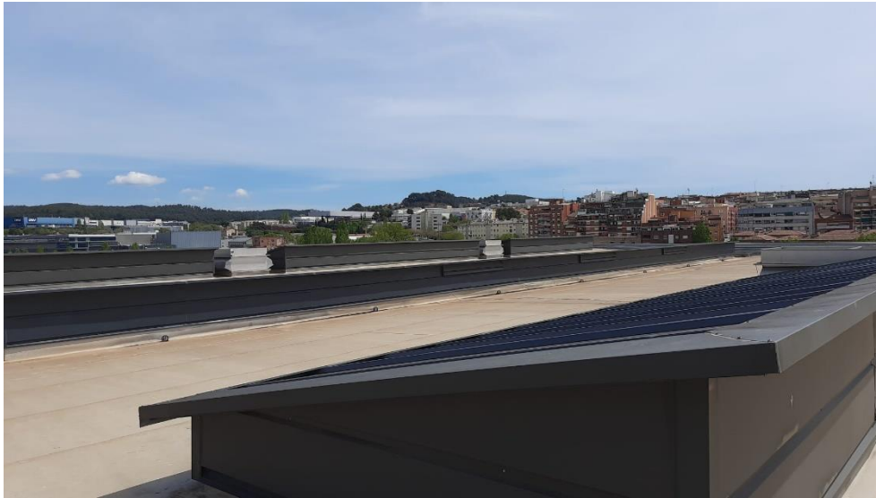
Il·lustració 1: vista de la zona nord de la coberta.
