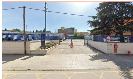
Zona d'accés al recinte
