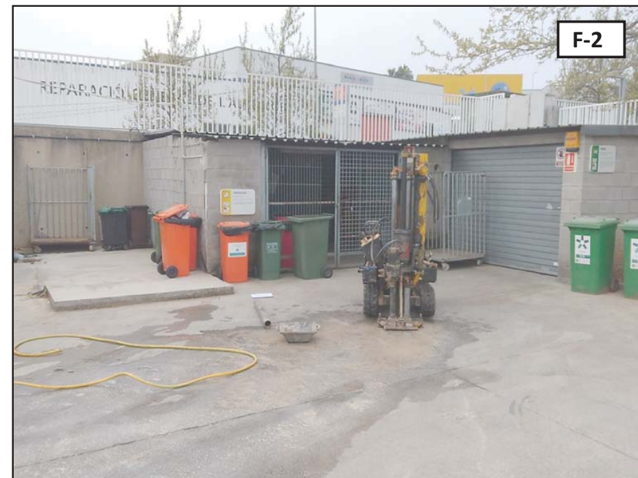
Fotografies 1 i 2: Detall de l'emplaçament de la màquina realitzant els assaigs de penetració dinàmica DPSH, P-1 i P-2, respectivament.
