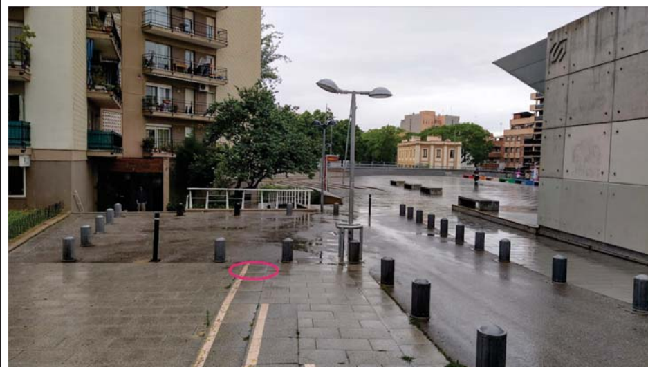
Fotografia: punt d'instal·lació de columna
