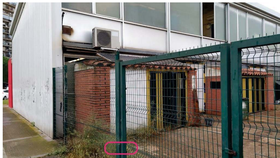
Fotografia: punt d'instal·lació de columna
