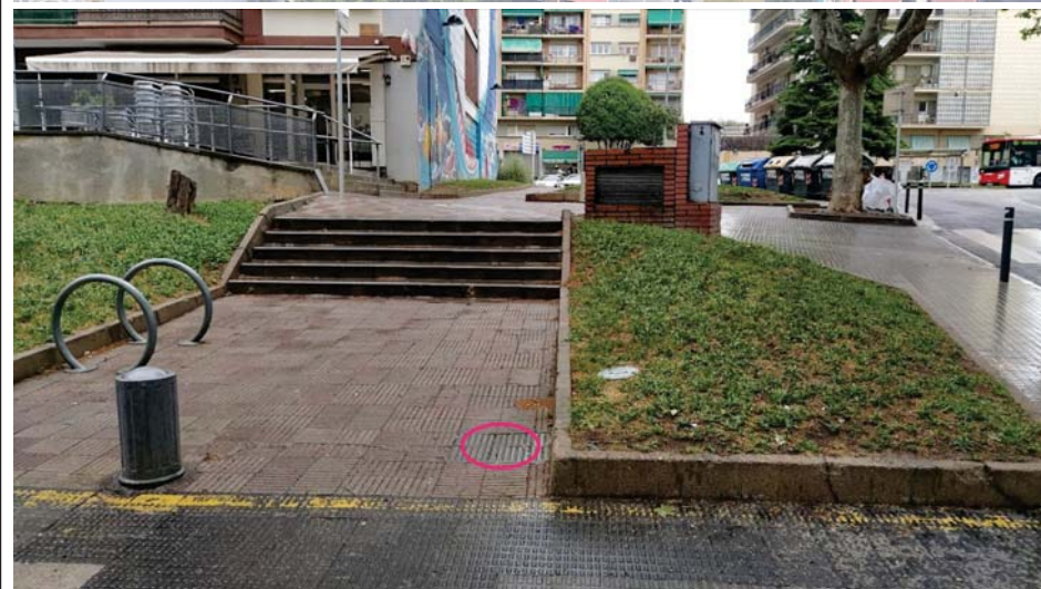
Fotografia: punt d'instal·lació de columna
