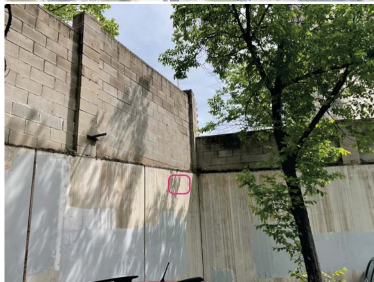
Fotografia: punt d'anclatge per bàcul en paret
