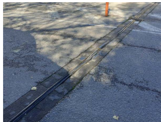
Detall junta pont sobre torrent dels Alous.
