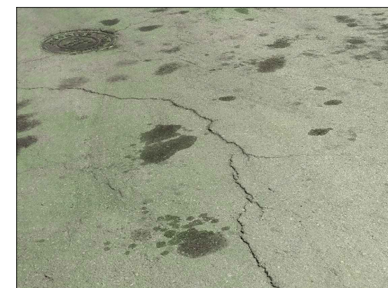
15. Cruïlla C. Wagner amb C. Chopin. Fissures. Tapa de registre enfonsada.
