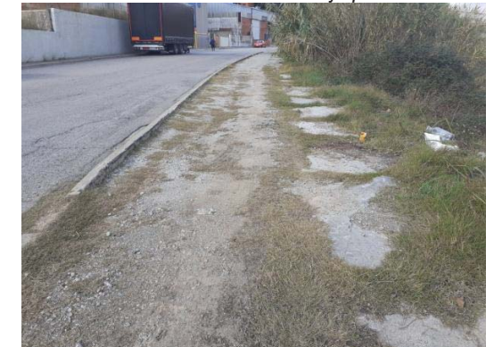
Detall c. Verdi amb trams de formigó.
