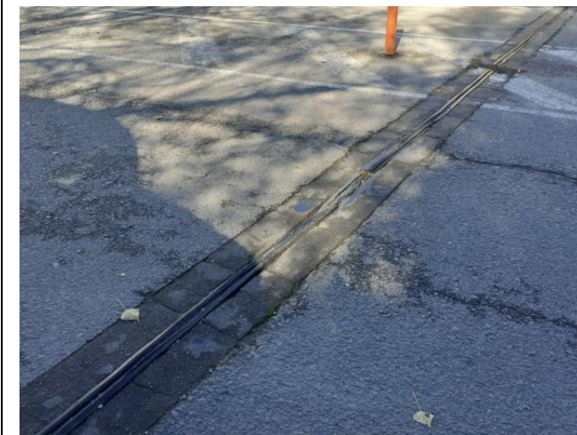
Detall junta de dilatació
