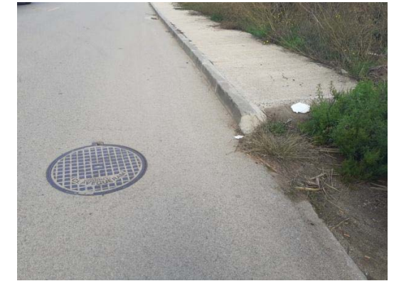
Límit àmbit actuació amb vorera ja pavimentada.
