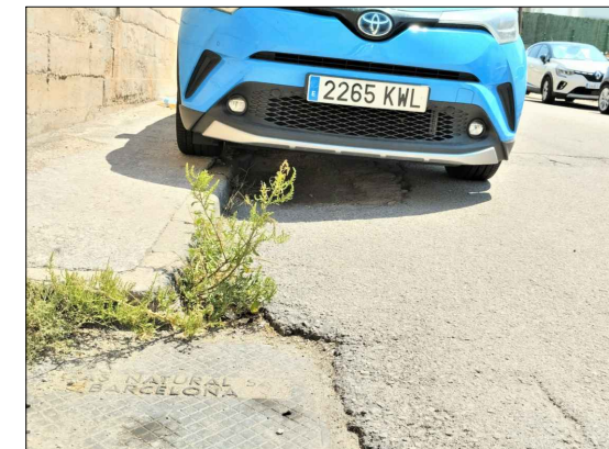
6. Tram 1 C. Chopin. Detall Flonjall. Arqueta enfonsada.
