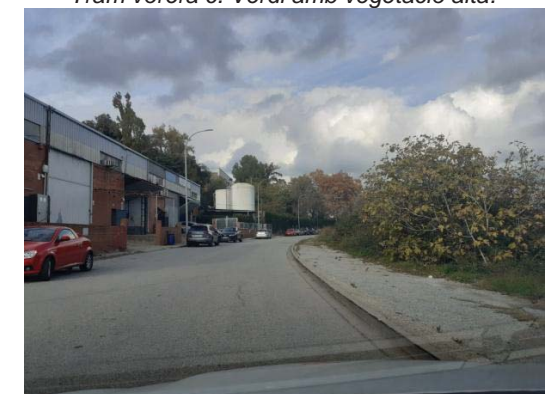
Tram vorera c. Verdi amb formigó, no enrasat amb vorada existent.
