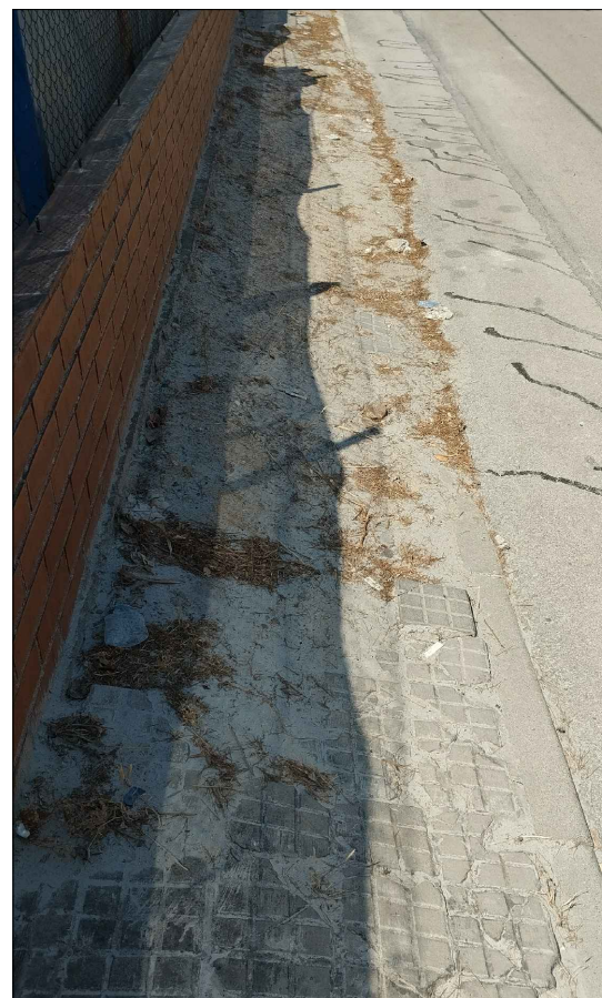
34. C. Beethoven. Vorera en mal estat, enfonsaments, desprendiments.
