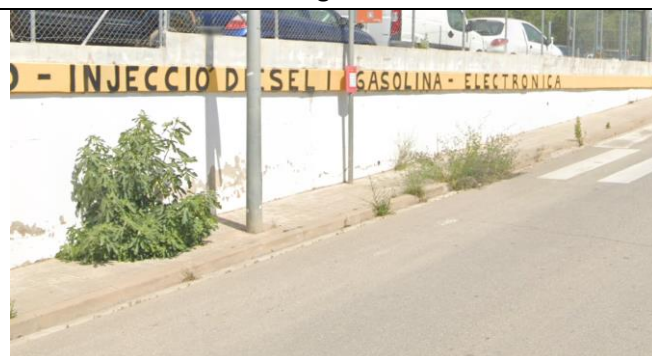
Vorera en mal estat. Vegetació en vorera
