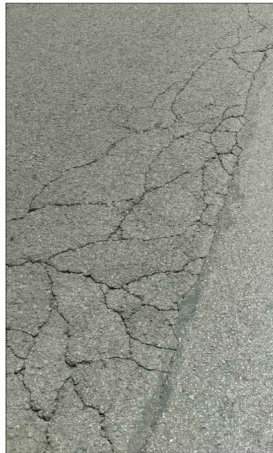
25. C. Beethoven. Fissures i Pell de cocodril en capa de rodadura.
