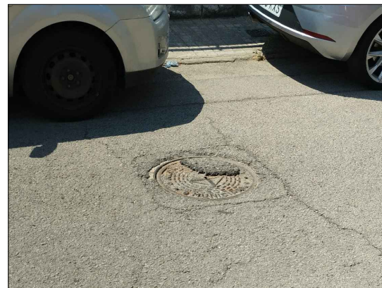
5. Tram 1 C. Chopin. Tapa de Registre Enfonsada. Fissures.
