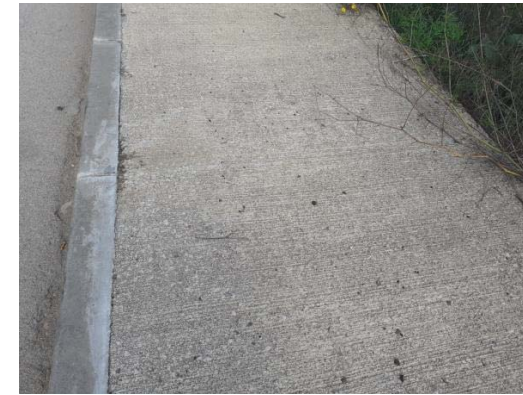
Tram vorera c. Verdi nord, ja pavimentat.
