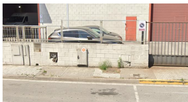
Vorera en mal estat. Vegetació en vorera
