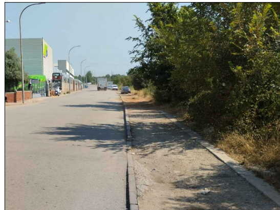
17. C. Verdi. Vorada en mal estat, enfonsada i malmesa. Sense Vorera. Presència de fang i vegetació.
