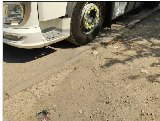
18. C. Verdi. Detall vorada en mal estat, enfonsada i malmesa. Sense Vorera.
