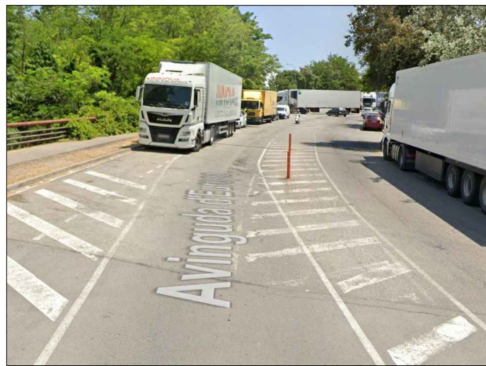
1. Pont al Carrer Leonardo Da Vinci. Fissures, trencaments, despreniments i deformacions.
