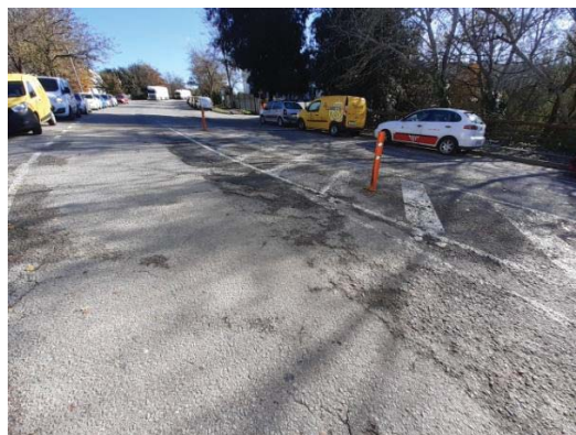
Paviment sobre pont torrent dels Alous.
