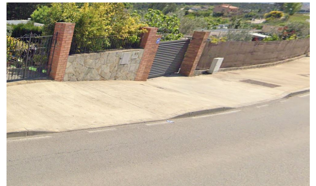
VORADA TIPUS T-2 FORMIGÓ PREFABRICAT (15x100x25 cm)
