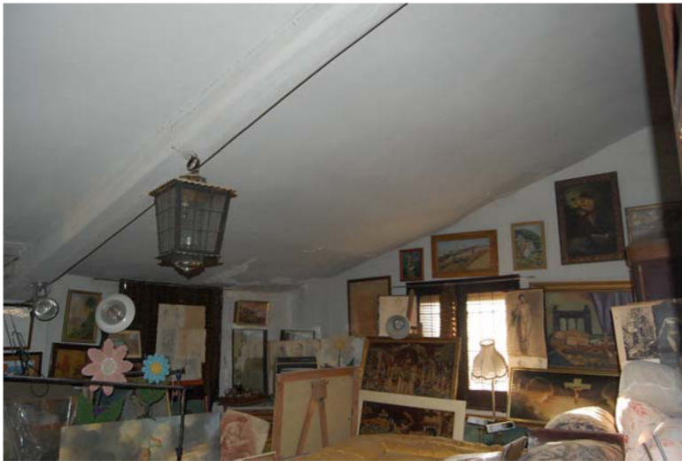
54. Habitació sota coberta (cel ras sobreposat)
