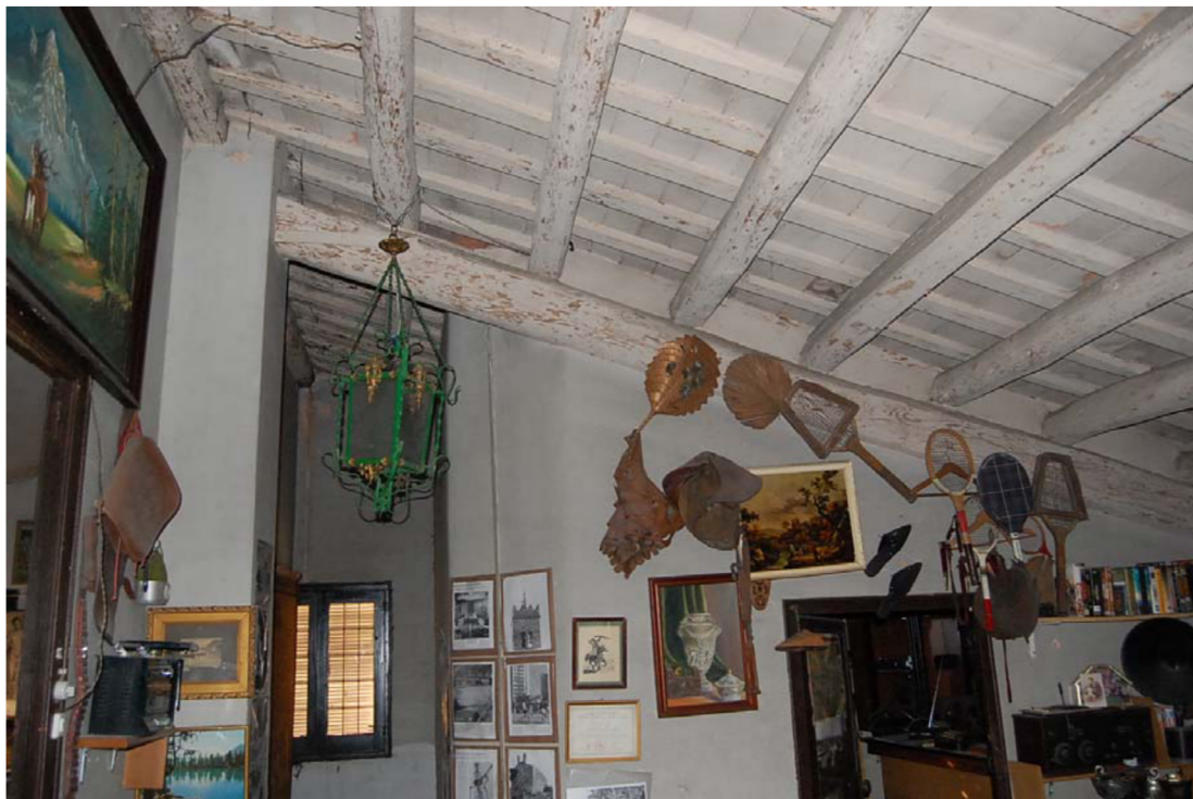
51. Sostre original sota la coberta
