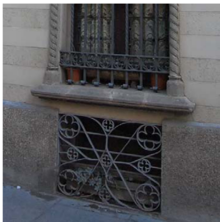
11. Ventilació del soterrani
