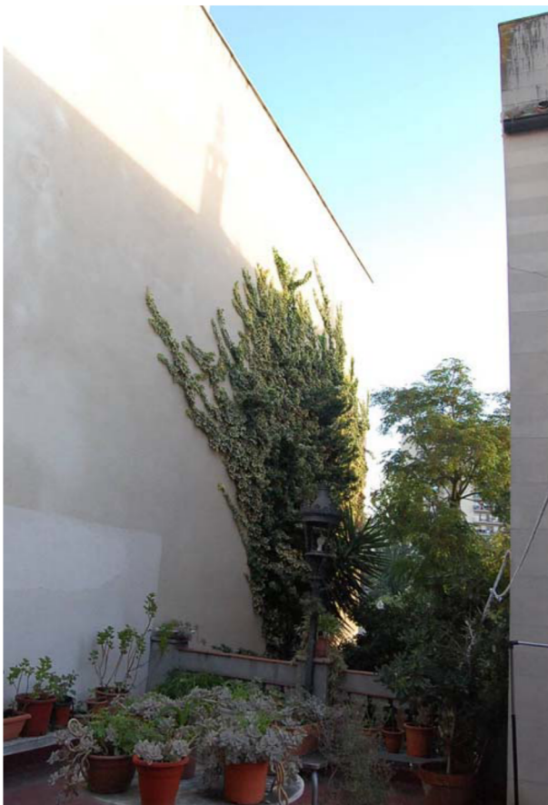
26. Paret mitgera de l'edifici Pearson
