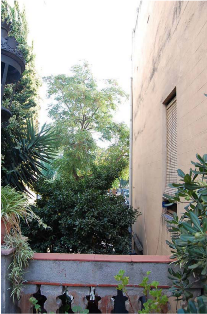
24. Façana est des del terrat de la planta primera
