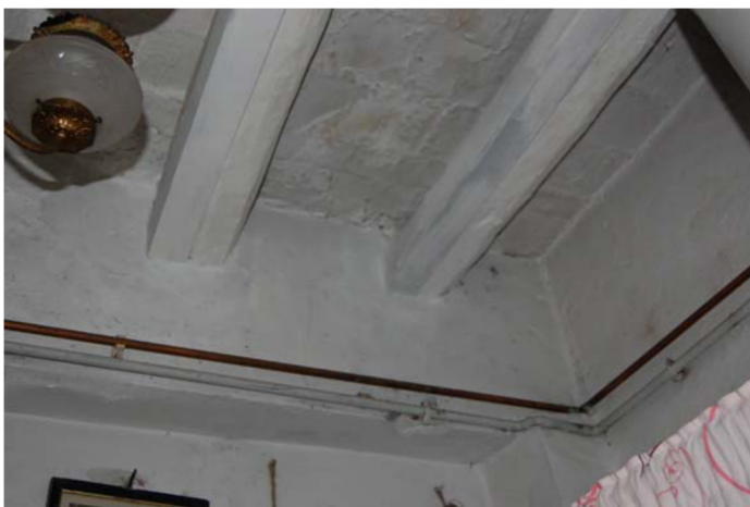
75. Sostre del rebost a la planta baixa
