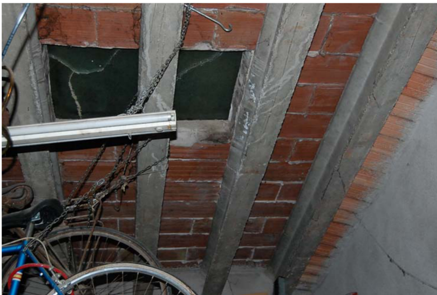
46. Sostre del garatge
