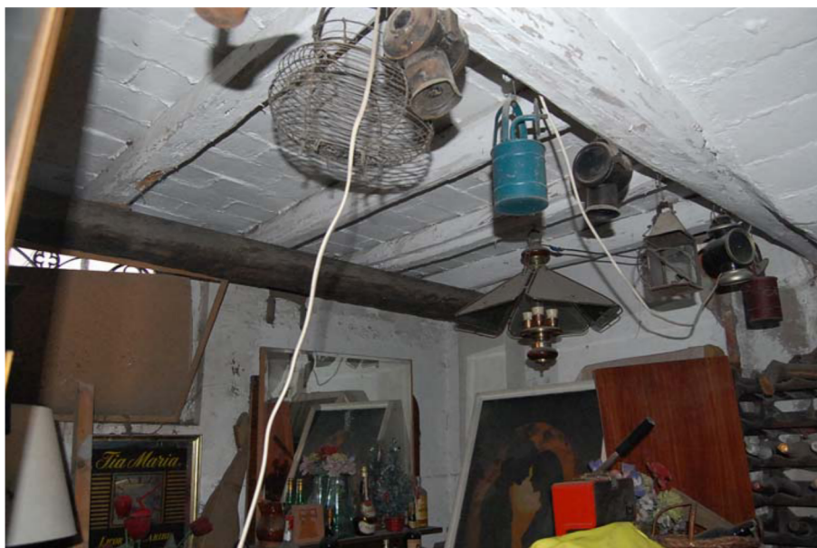
34. Antic accés a la planta soterrani des del local annex de la planta baixa (tapiat)
