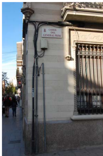
89. Instal·lacions a la façana
