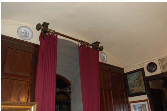
73. Volta de la sala interior de la planta baixa
