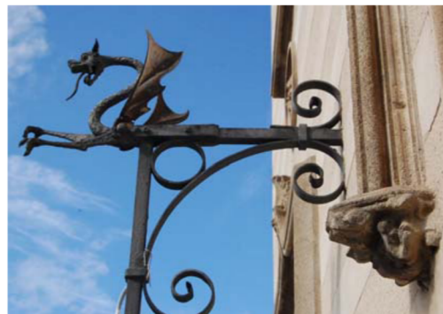
08. Detall de la forja del balcó
