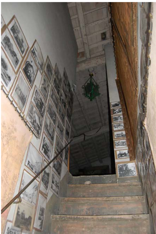
63. Accés a la planta sotacoberta
