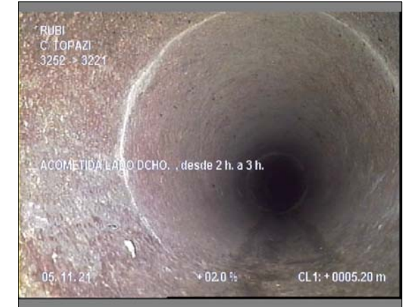
Foto: 3_3_28_A.JPG 5,2m, ACOMETIDA LADO DCHO. , desde 2 h. a 3 h.
