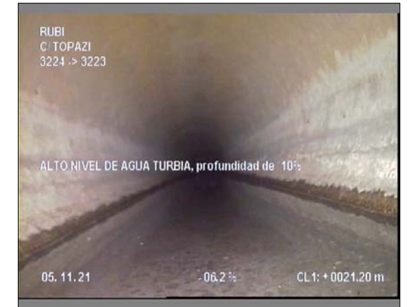
Foto: 1_1_3_A.JPG 21,2m, ALTO NIVEL DE AGUA TURBIA, profundidad de 10%
