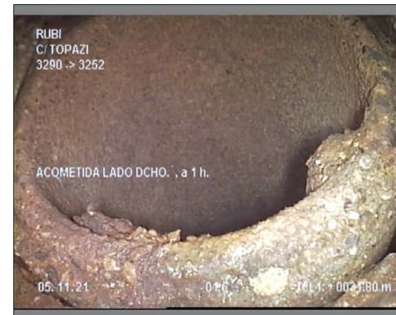
Foto: 2_2_19_A.JPG 31,8m, ACOMETIDA LADO DCHO. , a 1 h.
