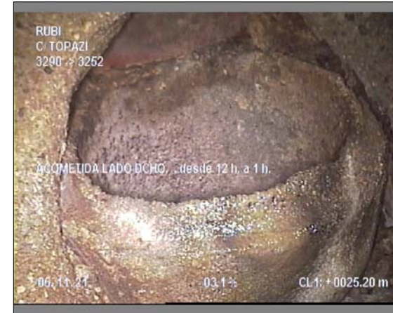
Foto: 2_2_17_A.JPG 25,2m, ACOMETIDA LADO DCHO. , desde 12 h. a 1 h.
