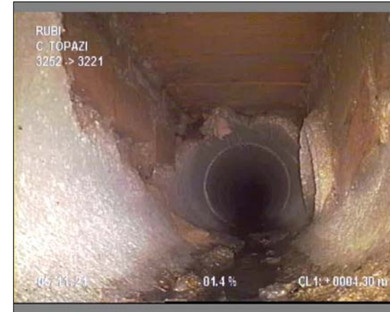
Foto: 3_3_27_B.JPG 4,3m, ROTURA PUNTUAL , REPARACION
