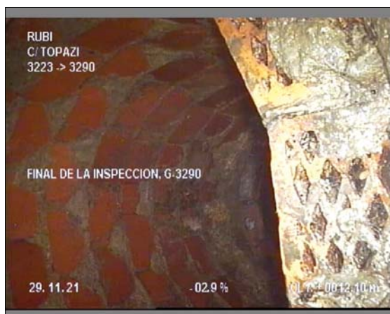
Foto: 6_6_43_A.JPG 12,1m, FINAL DE LA INSPECCION, G-3290
