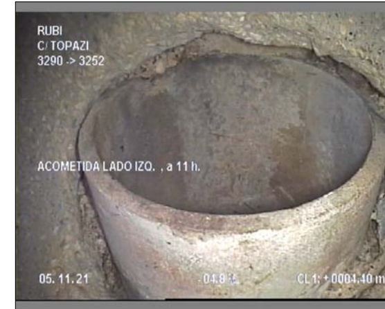
Foto: 2_2_10_A.JPG 4,4m, ACOMETIDA LADO IZQ. , a 11 h.
