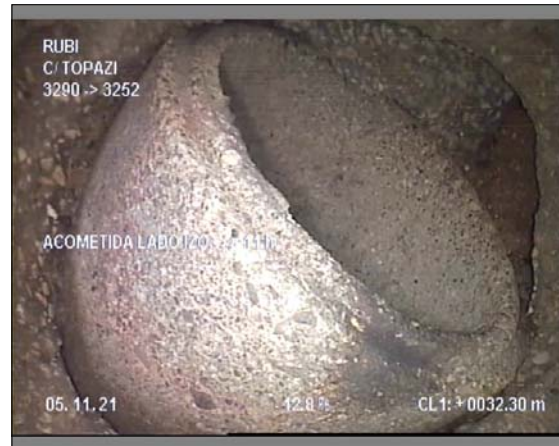
Foto: 2_2_21_A.JPG 32,3m, ACOMETIDA LADO IZQ. , a 11 h.
