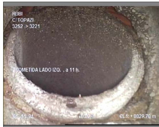
Foto: 3_3_32_A.JPG 29,7m, ACOMETIDA LADO IZO. , a 11 h.
