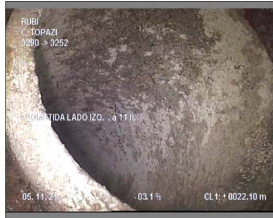
Foto: 2_2_14_A.JPG 22,1m, ACOMETIDA LADO IZO. , a 11 h.
