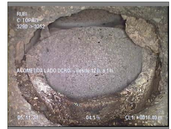
Foto: 2_2_12_A.JPG 16,4m, ACOMETIDA LADO DCHO. , desde 12 h. a 1 h.
