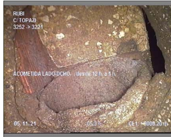
Foto: 3_3_25_A.JPG 0,2m, ACOMETIDA LADO DCHO. , desde 12 h. a 1 h.
