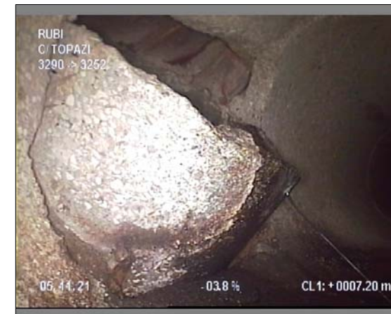
Foto: 2_2_11_B.JPG 7,2m, ACOMETIDA LADO IZQ. , a 11 h.
