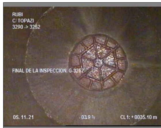
Foto: 2_2_23_A.JPG 35,1m, FINAL DE LA INSPECCION, G-3252
