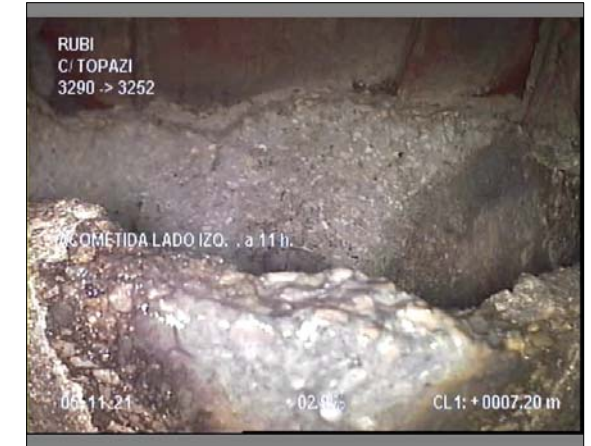
Foto: 2_2_11_A.JPG 7,2m, ACOMETIDA LADO IZQ. , a 11 h.
