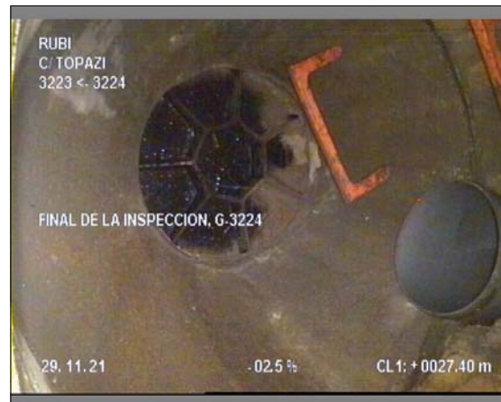
Foto: 4_4_38_A.JPG 27,4m, FINAL DE LA INSPECCION, G-3224
