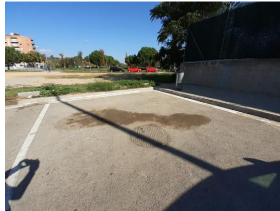
F8. Detall pou clavegueram en aparcament actual.
