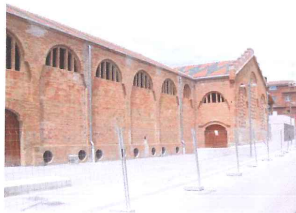
VISTA DE LA FAÇANA EST
