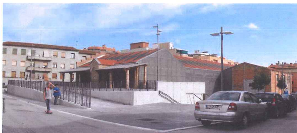
VISTA DE L'ACCÉS NORD
