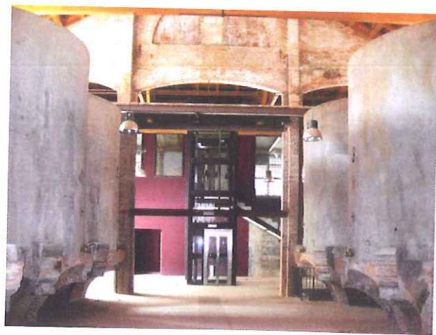
VISTA DE LA UNIÓ DE LA NAU PRINCIPAL AMB L'EDIFICI D'ENTRADA
