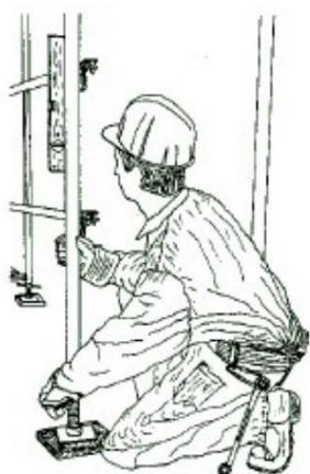
Figura 15. Comprobación de la nivelación vertical
