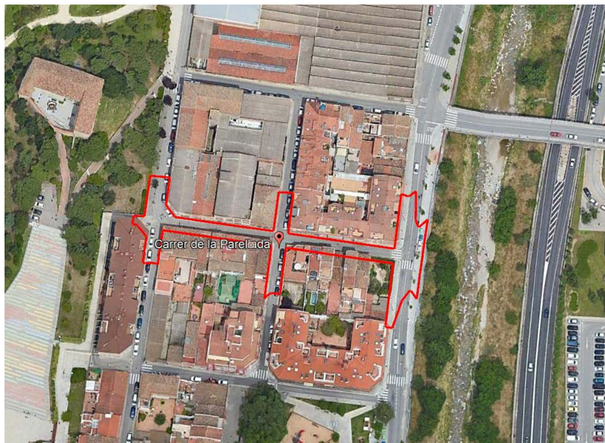
Fotografia 1: Àmbit Aixecament Carrer Parellada
