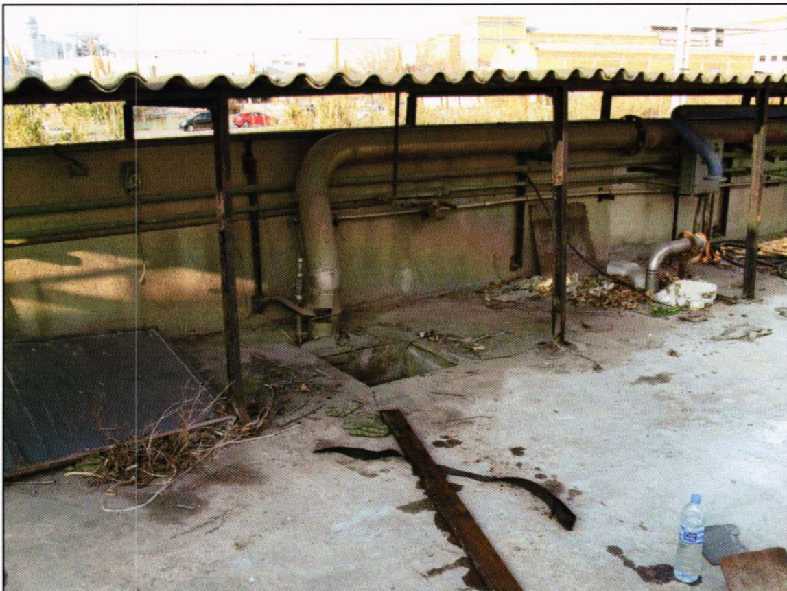
Fotografia 2. Vista de la zona on s'ubica el dipòsit de gas-oil enterrat
