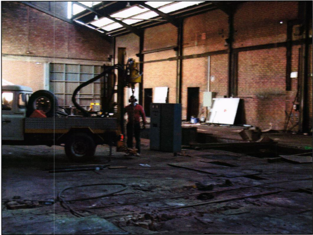
Fotografia 3. Màquina de sondeig a rotació treballant en el sondeigs S3 en la zona de fundició.
