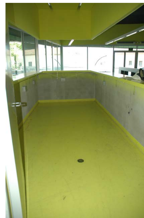
ÀMBIT D'ACTUACIÓ. VISTA DE LA BARRA DEL BAR ACTUAL
