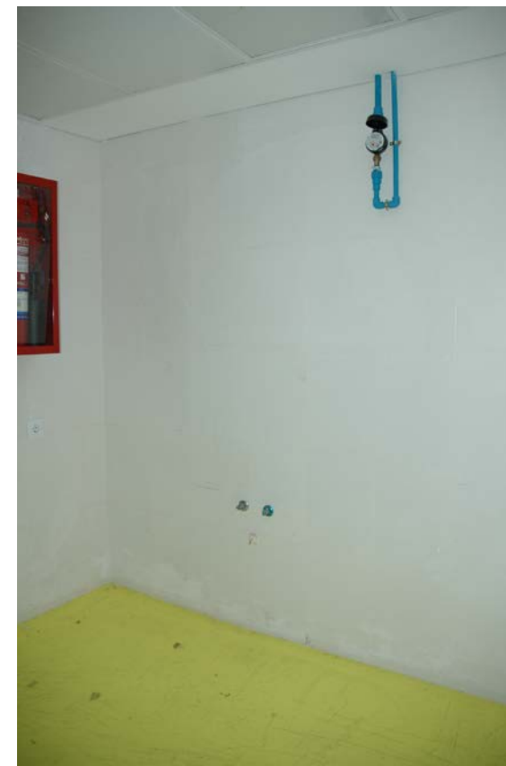
ÀMBIT D'ACTUACIÓ. VISTA DE LA CUINA
