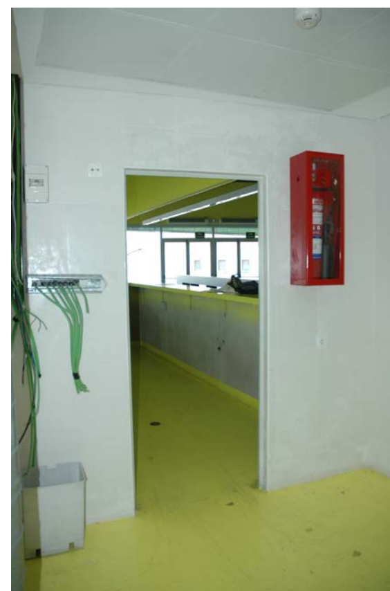
ÀMBIT D'ACTUACIÓ. VISTA DE LA CUINA
