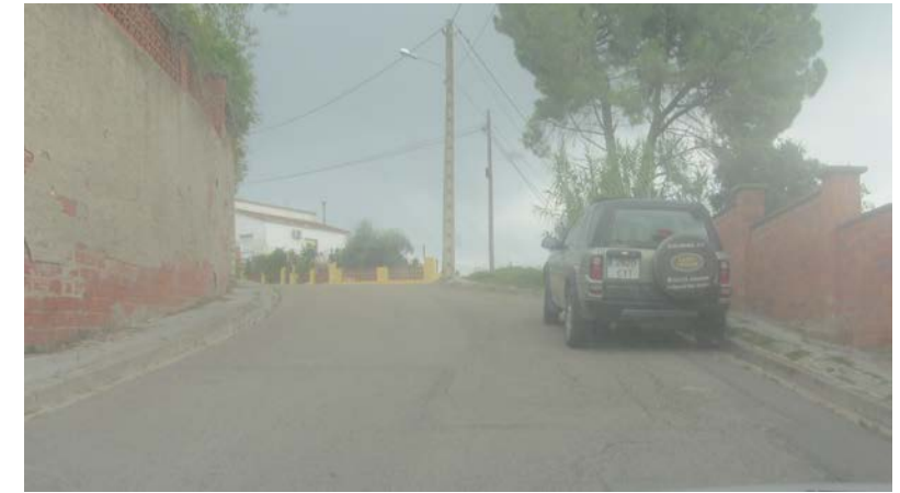
FOTO 15. Actuació AP_09. Fressat paviment carril dret (s/imatge)
