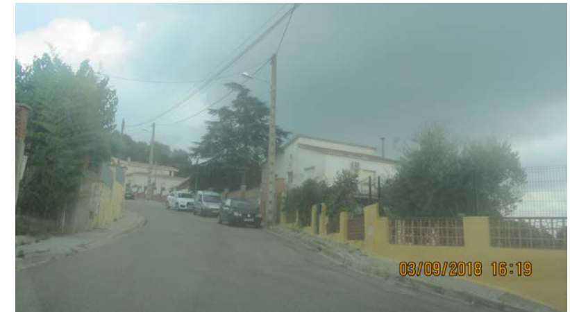
FOTO 17. Actuació AP_10. Reparació flonjall costat dret (passada la cruïlla)
