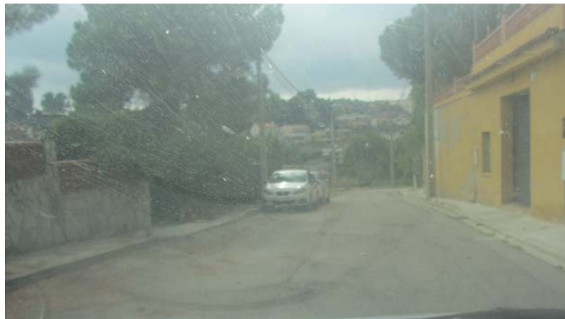
FOTO 35. Actuari AP_27. Reparació flonjall per arrels
