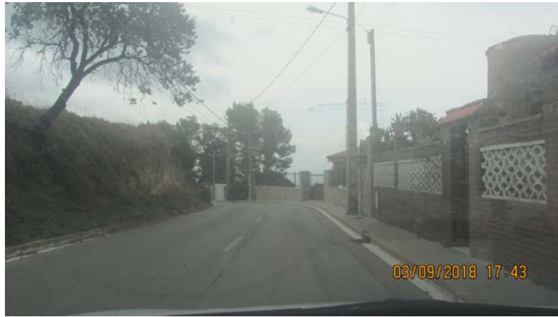
Foto 27. Actuació AP_19. Fressat paviment
