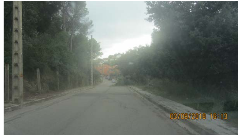
FOTO 12. Actuació AP_07. Reparació de flonjall (uns metres més endavant que AP_06) per culpa d'arrels.
