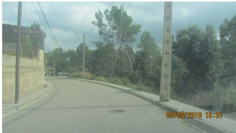
FOTO 2. Actuació AB_01. Instal·lació nova barana
