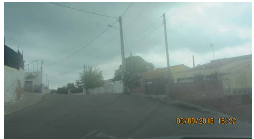
FOTO 39. Actuari AP_31. Fressat paviment calçada
