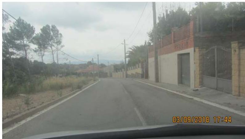
Foto 28. Actuació AP_20. Fressat paviment
