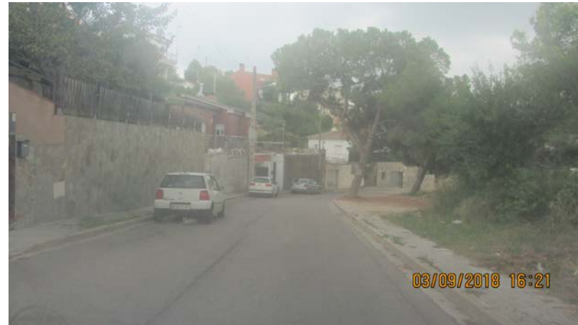
FOTO 37. Actuari AP_29. Reparació vorera dreta per assentament.
