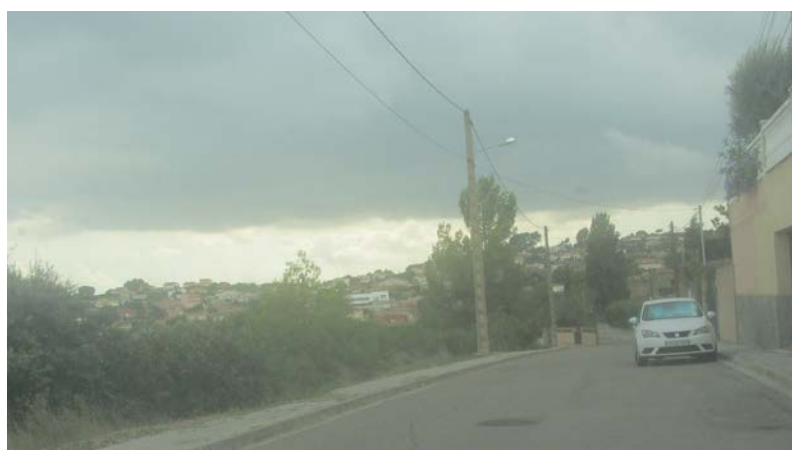
FOTO 62. Actuariació AP_50. Reparació vorera esquerra
