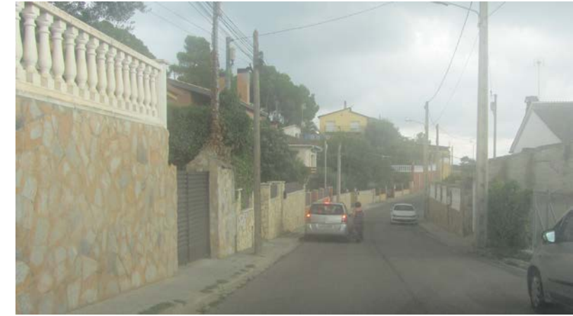
FOTO 40. Actuari AP_32. Reparació vorera dreta per assentament.
