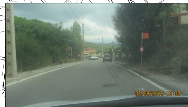
AP_35 Reparació vorera AP_36 Pavimentar vorera
