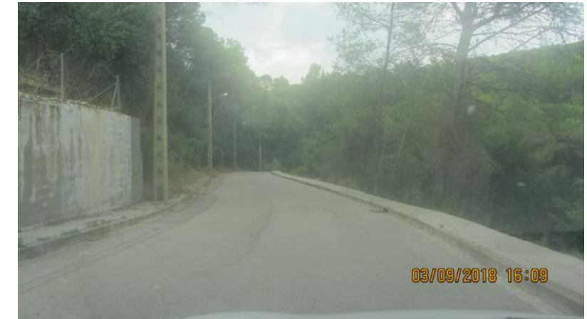
FOTO 7. Actuació AB_03. Instal·lació nova barana
