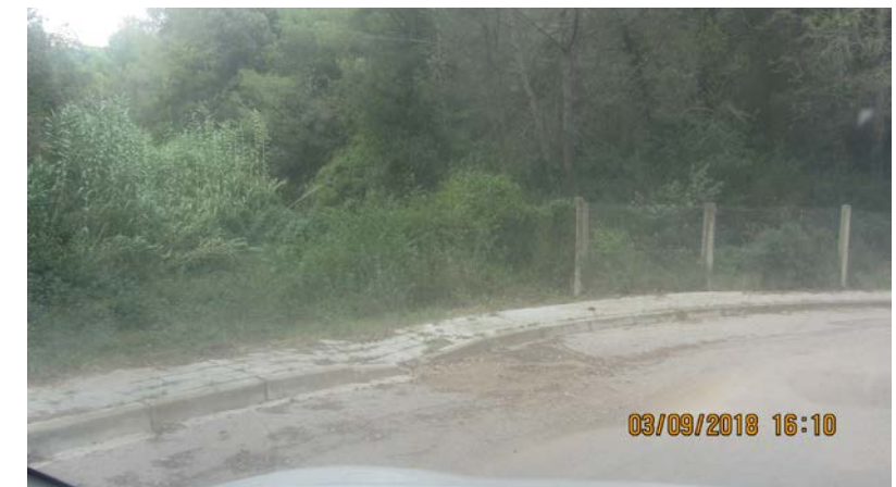
FOTO 9. Actuació AP_05. Reparació flonjall i reparació vorera per assentament de la base
