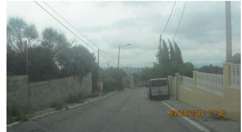
Foto 24. Actuació AP_16. Fressat paviment
