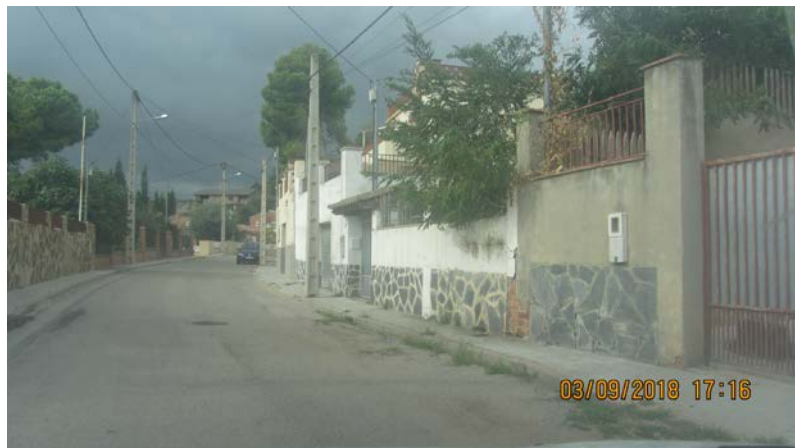
FOTO 36. Actuari AP_28. Reparació flonjall per arrels
