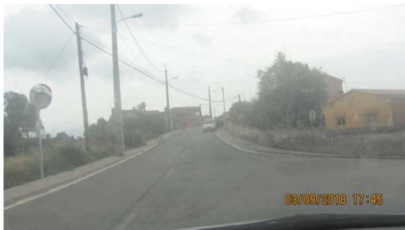
Foto 29. Actuació AP_21 Fressat paviment
