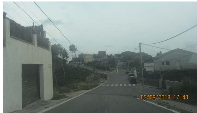
Foto 31. Actuació AP_23 Fressat paviment
