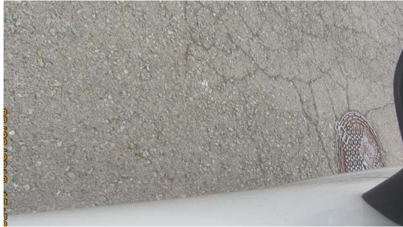
FOTO 1. Actuació AP_01. Reparació de flonjall
