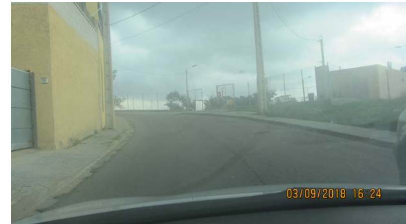
FOTO 41 Actuari AP_33. Fressat paviment calçada
