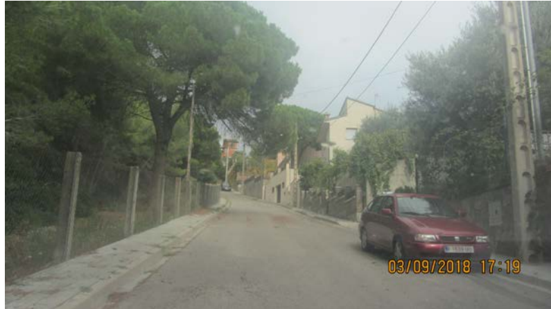
FOTO 34. Actuari AP_26. Reparació flonjall per arrels
