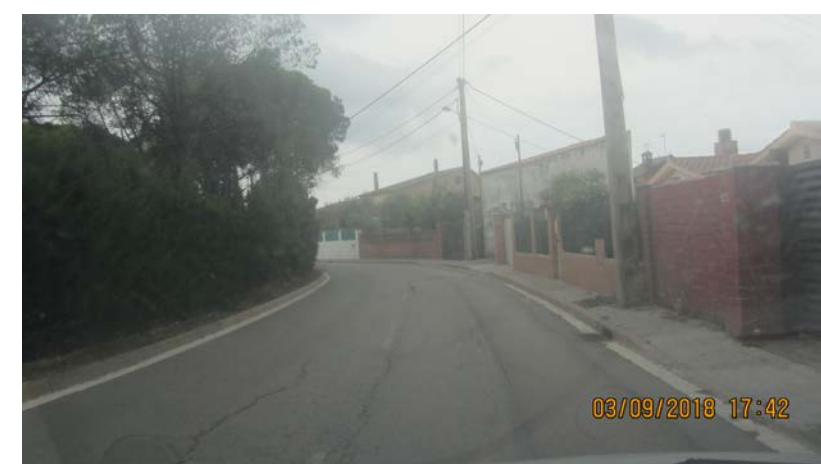
Foto 26. Actuació AP_18. Fressat paviment
