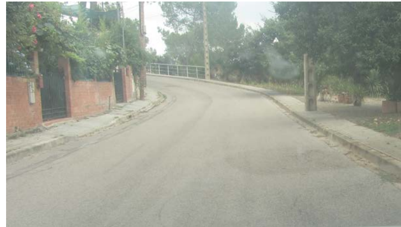
FOTO 4. Actuació AP_03. Flonjall rodada dreta (s/imatge) per arrels
