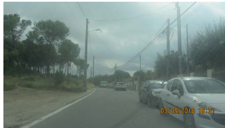
FOTO 48. Actuació AP_39. Pavimentar vorera esquerra
