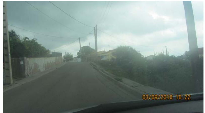
FOTO 38. Actuari AP_30. Reparació vorera dreta per assentament.
