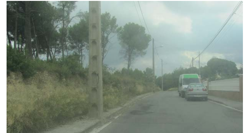
FOTO 50. Actuació AP_38. Reparació flonjall carri esquerra
