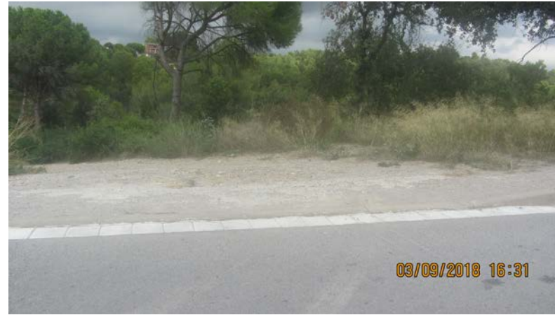
FOTO 46. Actuació AP_37. Pavimentar vorera en terres
