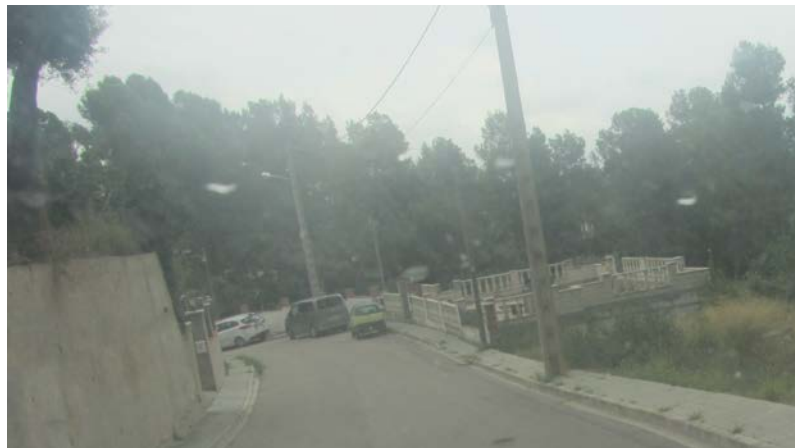
FOTO 53. Actuació AB_04. Instal·lació barana vorera dreta
