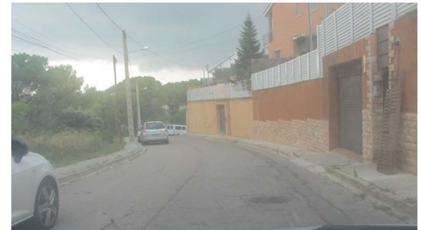
FOTO 58. Actuació AP_47. Reparació flonjall carril dret
