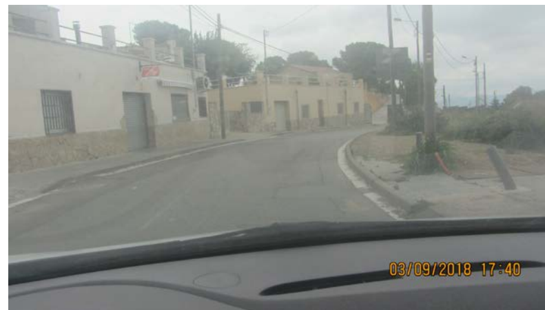
Foto 22. Actuació AP_15. Pavimentar vorera en terres.
