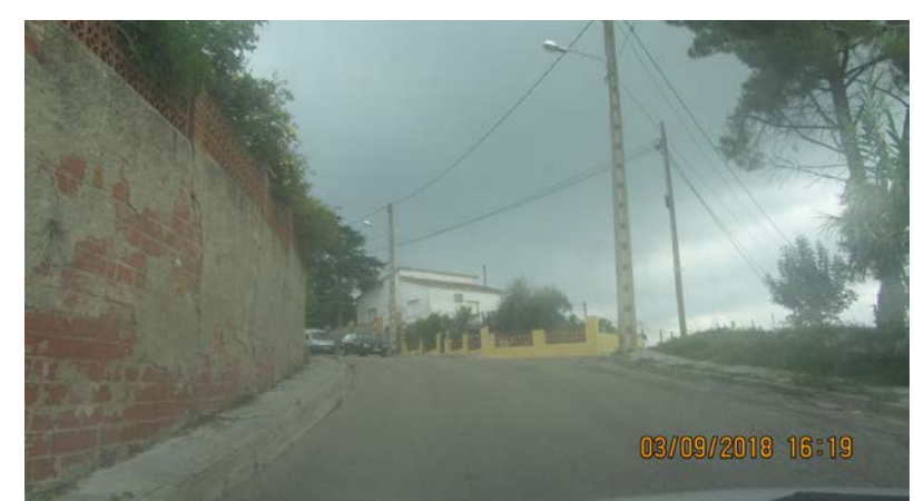
FOTO 16. Actuació AP_09. Reparació vorera costat dret
