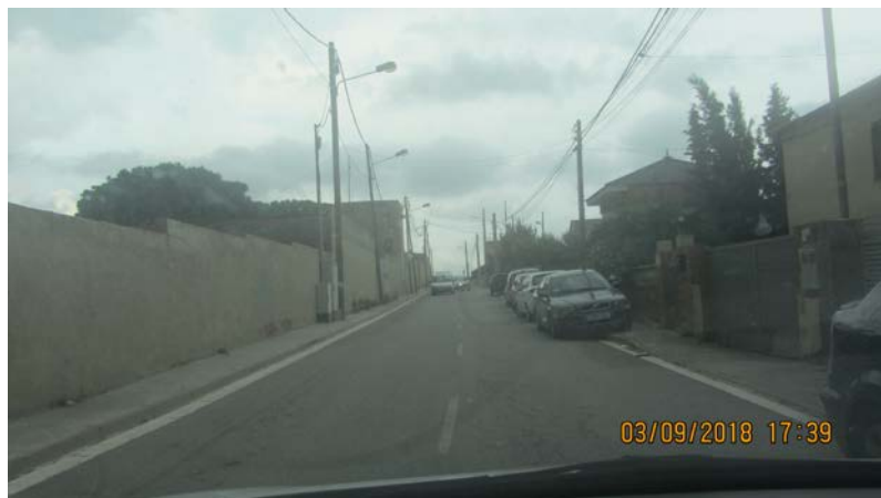
FOTO 19. Actuació AP_13. Reparació flonjall carril dret (s/imatge)
