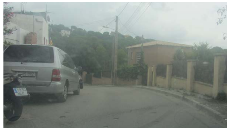
FOTO 56. Actuació AP_45. Flonjall als dos carrils i pavimentar vorera dreta (s/imatge)
