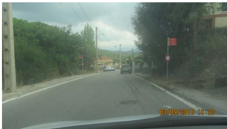
FOTO 45. Actuació AP_36. Pavimentar vorera marge dret
