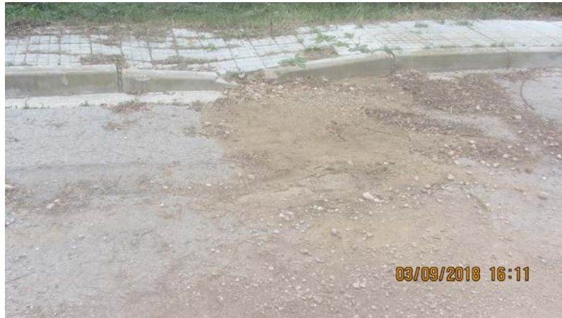
FOTO 10A. Actuació AP_05. Detall assentament en vorera i en calçada.
