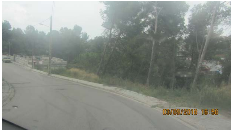
FOTO 52. Actuació AP_42. Reparació vorera dreta
