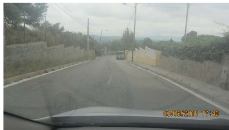
Foto 23. Actuació AP_16. Fressat paviment
