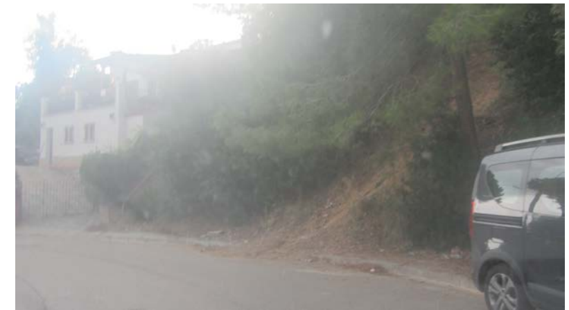
FOTO 59. Actuació AT_05. Reperfilat talús
