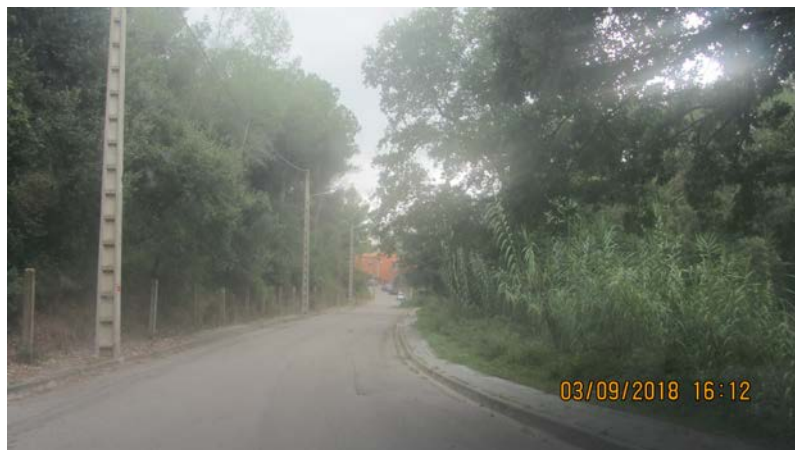
FOTO 11. Actuació AP_06. Reparació de flonjall
