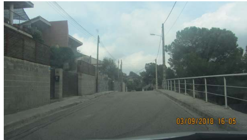
FOTO 5. Actuació AB_02. Adequació barana existent amb reixat metàl·lic
