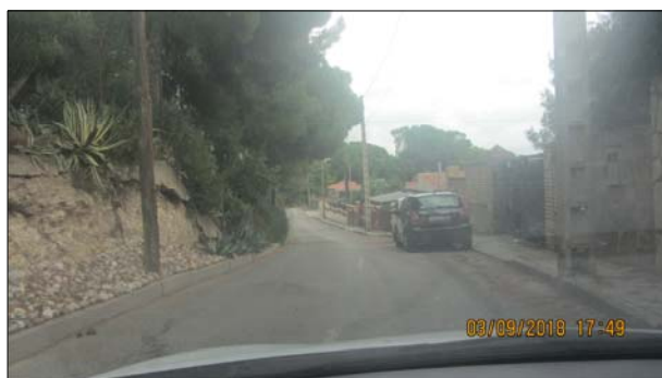
AP_25 Reparació florjall (per arrels)
