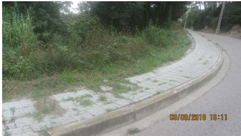
FOTO 10B. Actuació AP_05. Mateixa zona que anterior foto però detall de vorera dreta (amb assentament també de la seva base).
