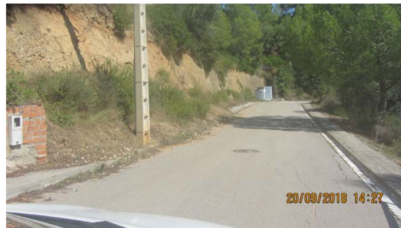
FOTO 19. Actuació AT_06.Reperfilat talús
