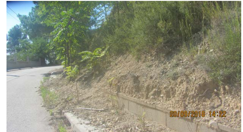
FOTO 7. Actuació AT_03. Reperfilat talús
