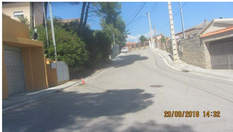
FOTO 11. Actuariació AP_02. Reparació flonjall (abalisat con)
