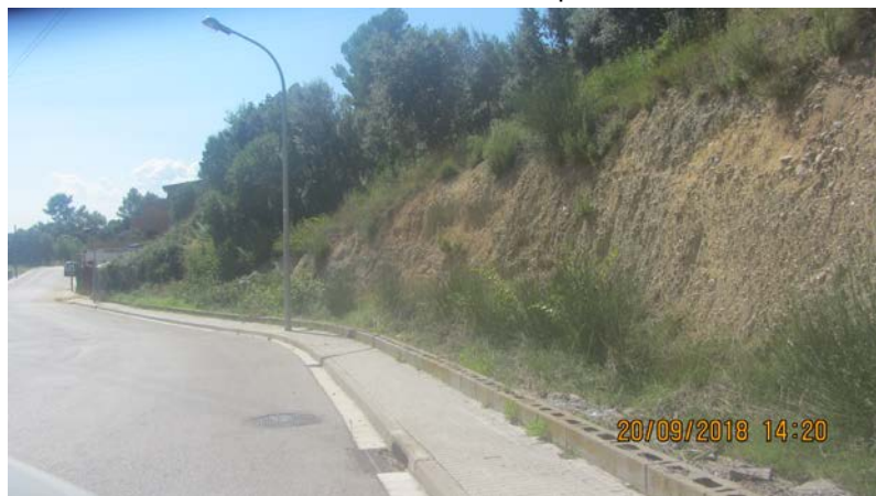
FOTO 3. Actuació AT_01. Reperfilat talús
