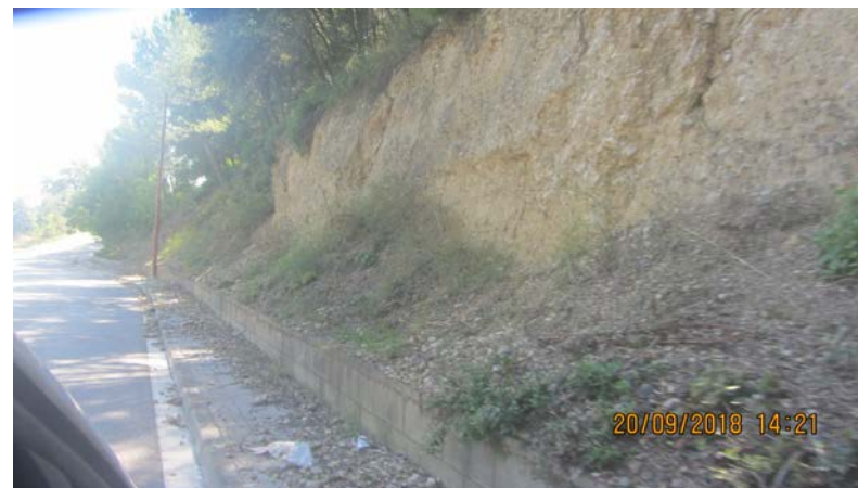
FOTO 5. Actuació AT_02. Reperfilat talús
