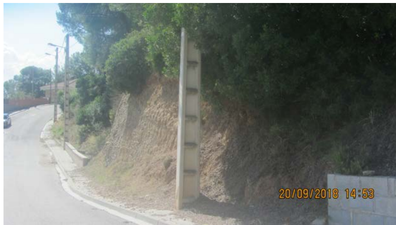
FOTO 33. Actuarió AT_08.Reperfilat talús esquerra
