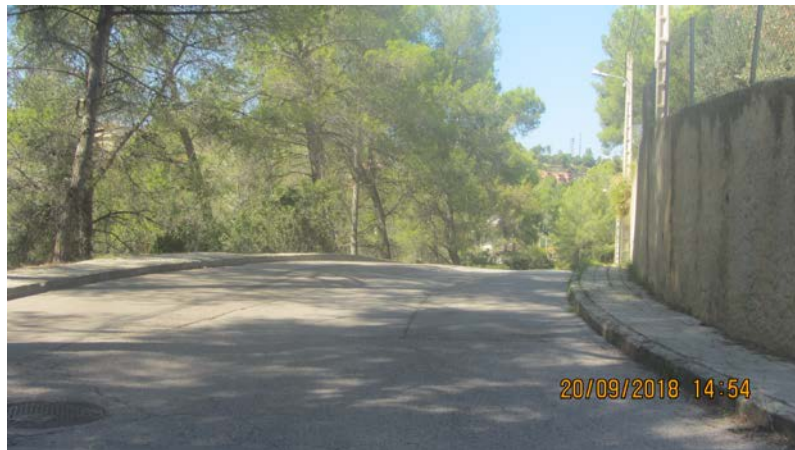
FOTO 34. Actuarió AP_10.Reparació flonjall a tot l'ample de calçada
