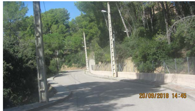
FOTO 28. Actuarió AB_05.Instal·lar nova barana costat esquerra
