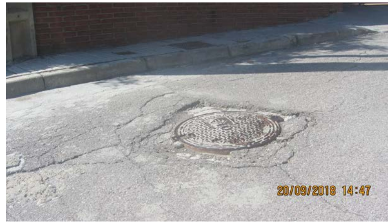
FOTO 27. Actuarió AP_09.Detall reparació flonjall
