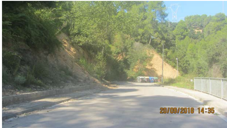
FOTO 14. Actuació AT_05.Reperfilat talús
