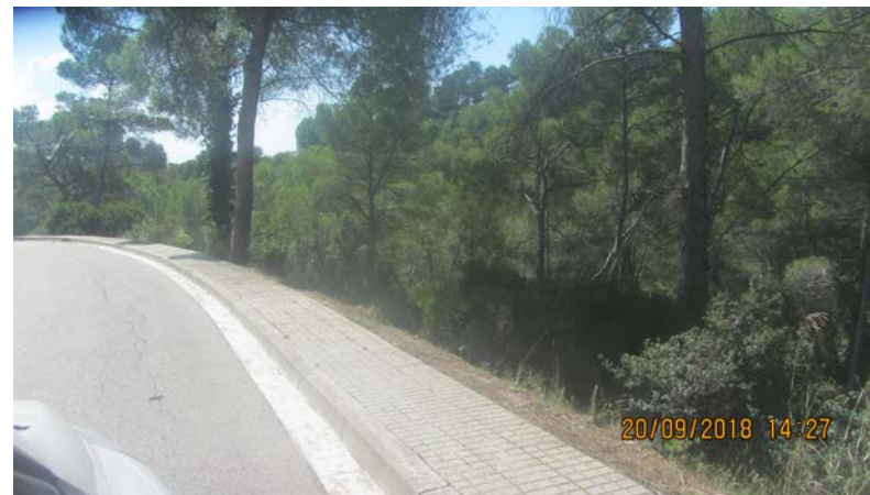
FOTO 18. Actuació AB_04.Instal·lació nova barana
