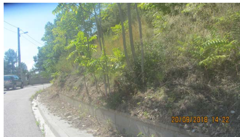
FOTO 6. Actuació AT_03. Reperfilat talús
