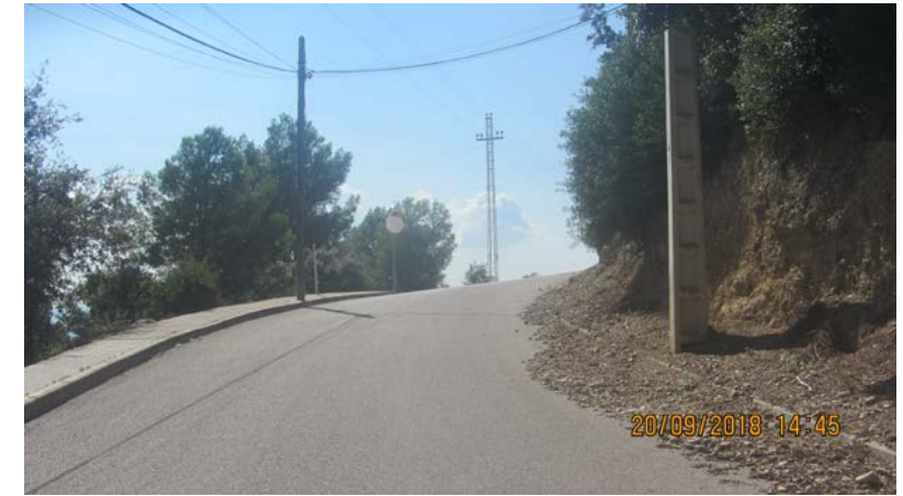
FOTO 29. Actuarió AB_06.Instal·lar nova barana costat esquerra
