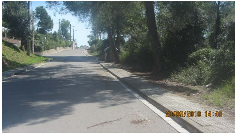
FOTO 23. Actuarió AP_06.Reparació vorera
