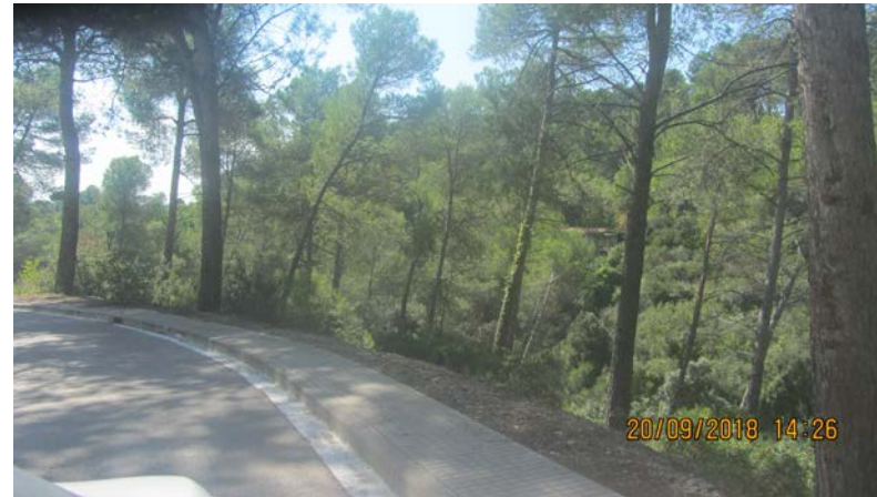
FOTO 17. Actuació AB_03.Instal·lació nova barana
