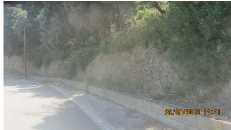
FOTO 4. Actuació AT_02. Reperfilat talús
