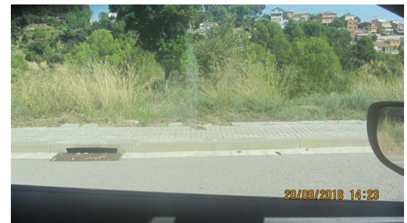
FOTO 9. Actuació AP_01. Reparació vorera
