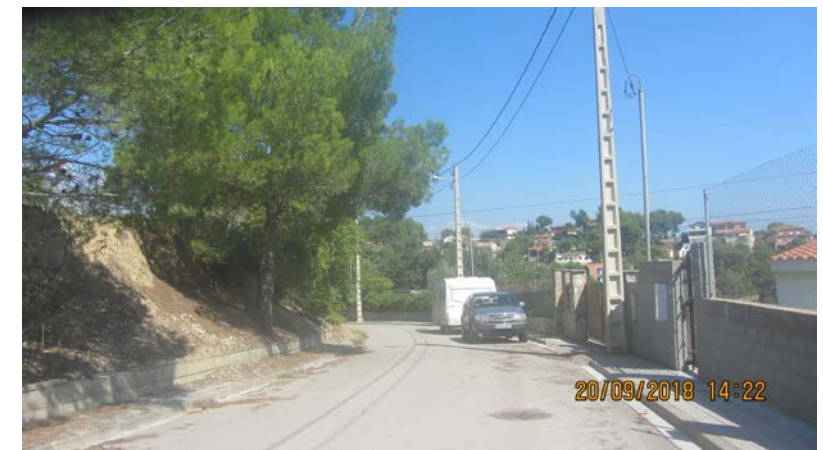
FOTO 8. Actuació AT_03. Reperfilat talús
