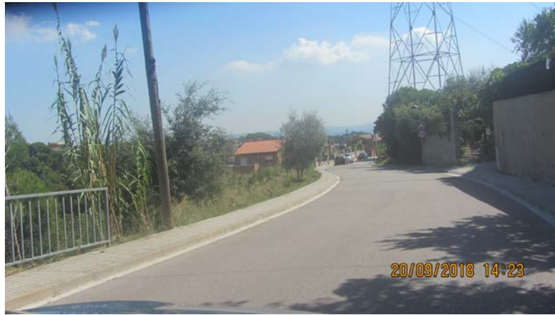
FOTO 10. Actuariació AB_01. Nova barana perllongant l'existent
