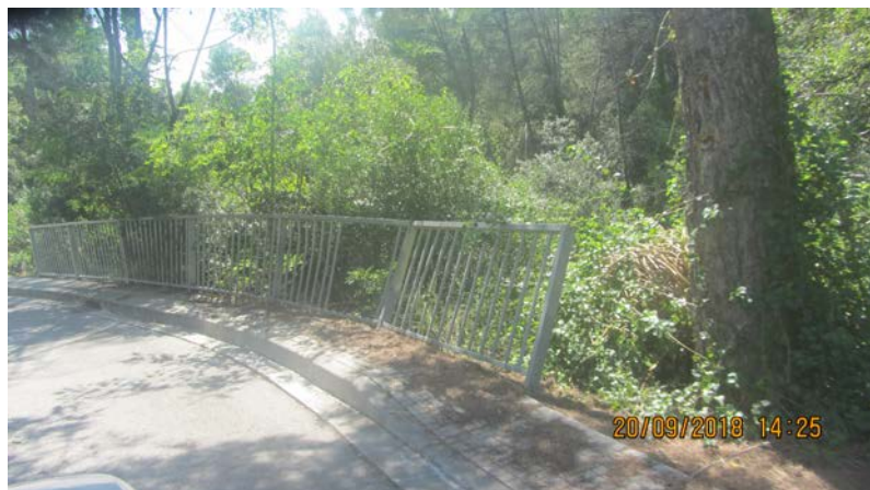
FOTO 16. Actuació AB_02.Substitució barana en mal estat
