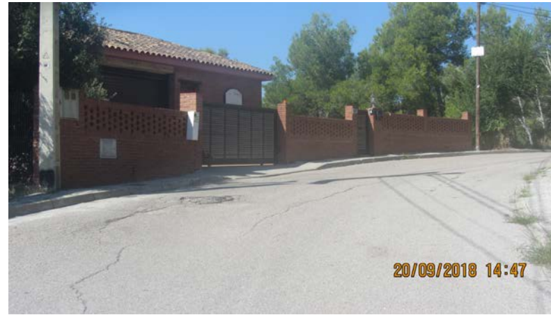
FOTO 26. Actuarió AP_09.Reparació flonjall carril esquerra
