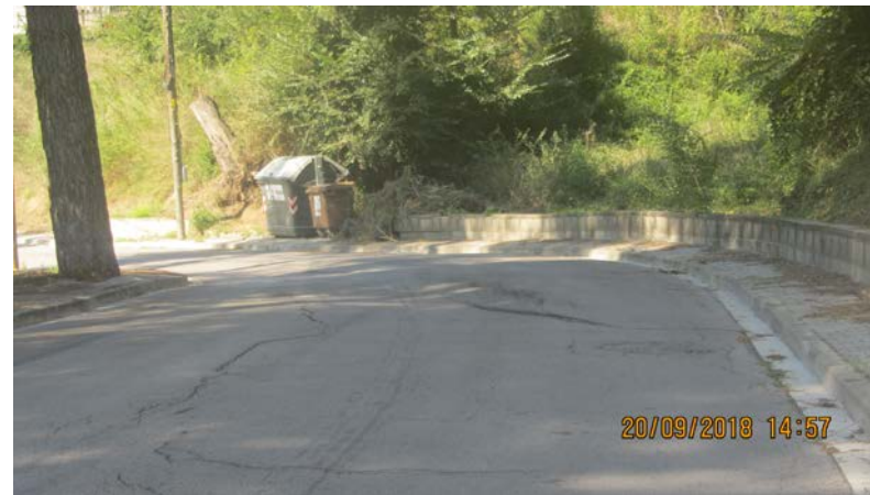
FOTO 37. Actuarió AP_11. Reparació flonjall a tot l'ample de calçada
