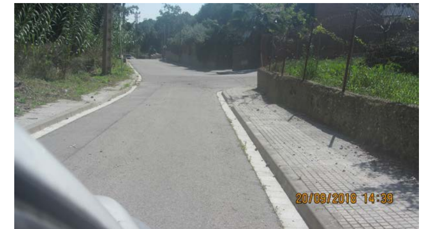
FOTO 21. Actuació AP_05.Reparació vorera cantonada dreta
