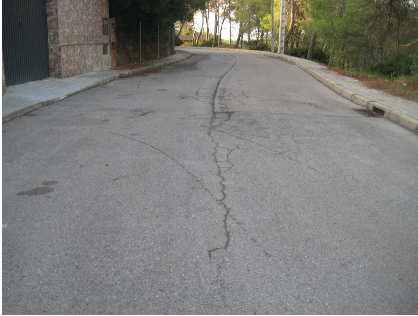
Fisura longitudinal
