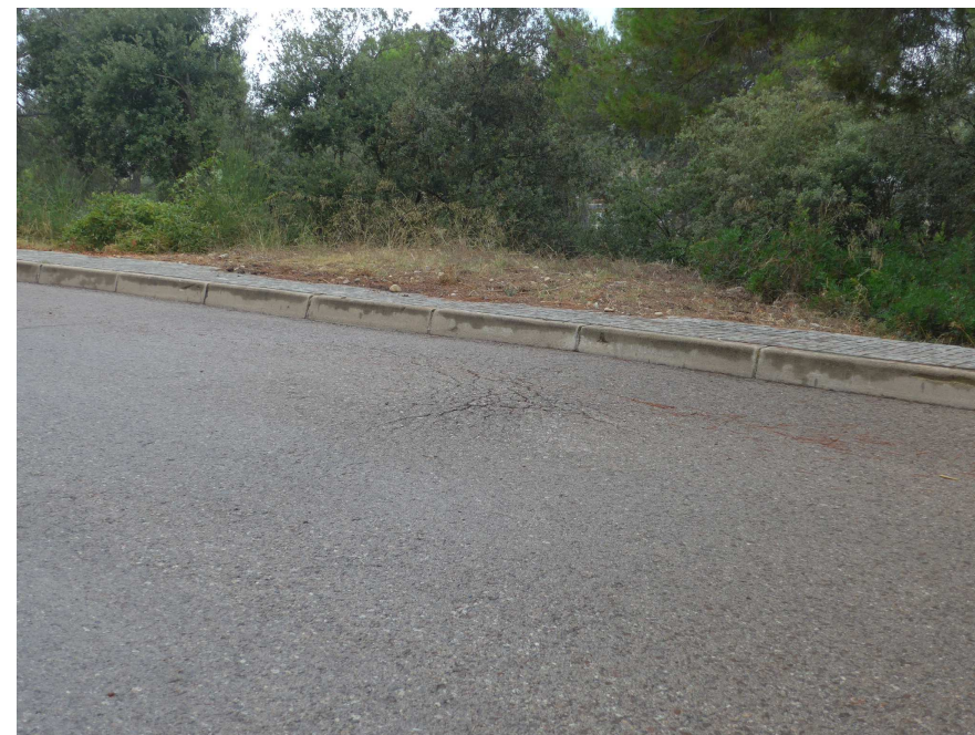
Aixecaments puntuals de la calçada
