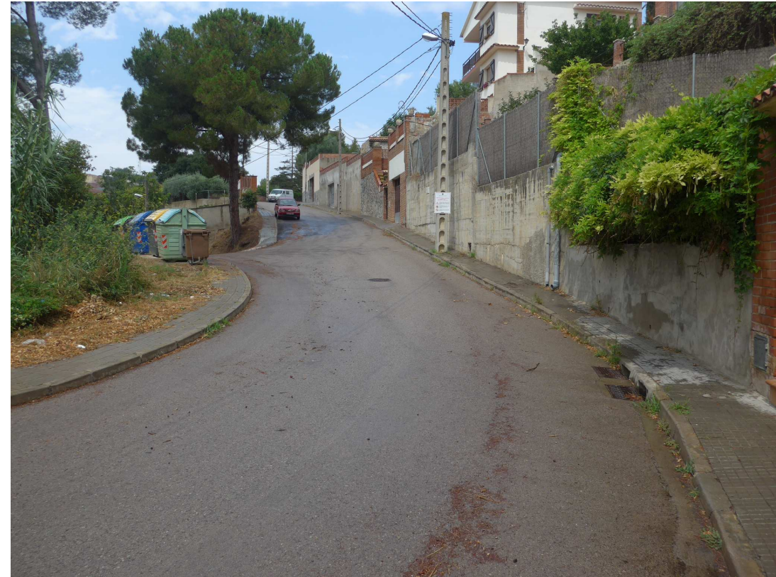
Tram de calçada amb flonjalls i esgotada
