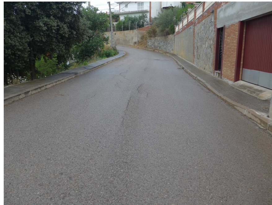
Fisures longitudinals
