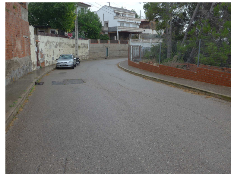
Fissures longitudinals en calçada
