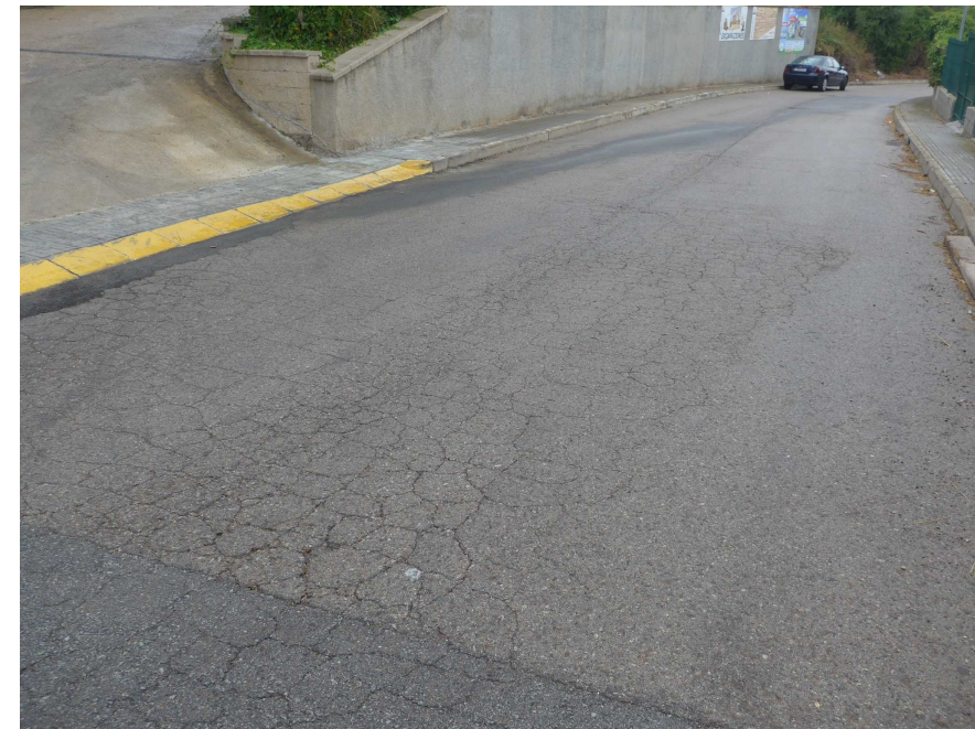
Calçada esgotada
