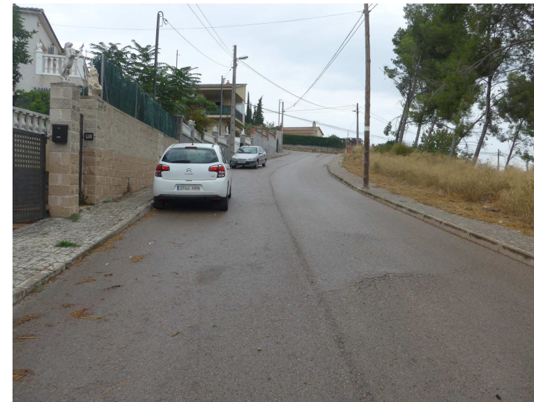
Fissures longitudinals en calçada
