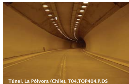
Túnel, La Pólvora (Chile). T04.TOP404.P.DS
