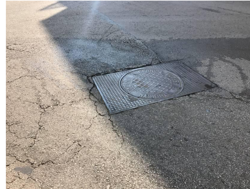
Estat del ferm i tapa de registre
