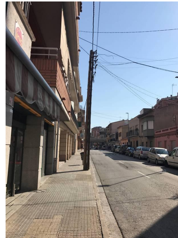
Xarxa elèctrica i poste
