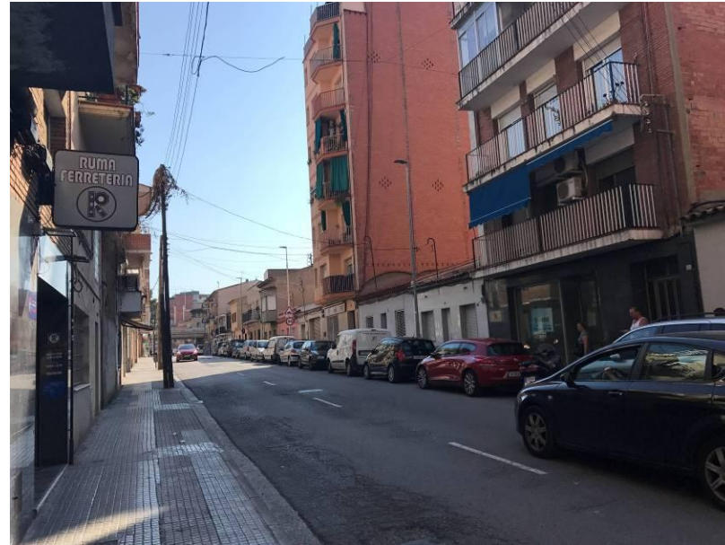
Xarxa elèctrica i poste
