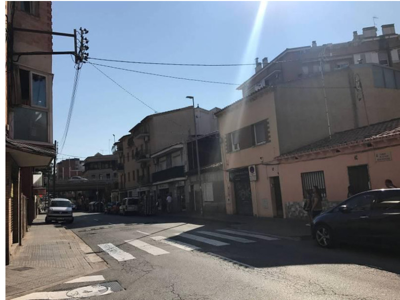
Xarxa elèctrica aèria
