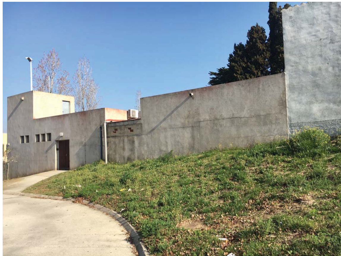
Façana Sud de l'edifici administratiu del Cementiri Municipal de Rubí.
