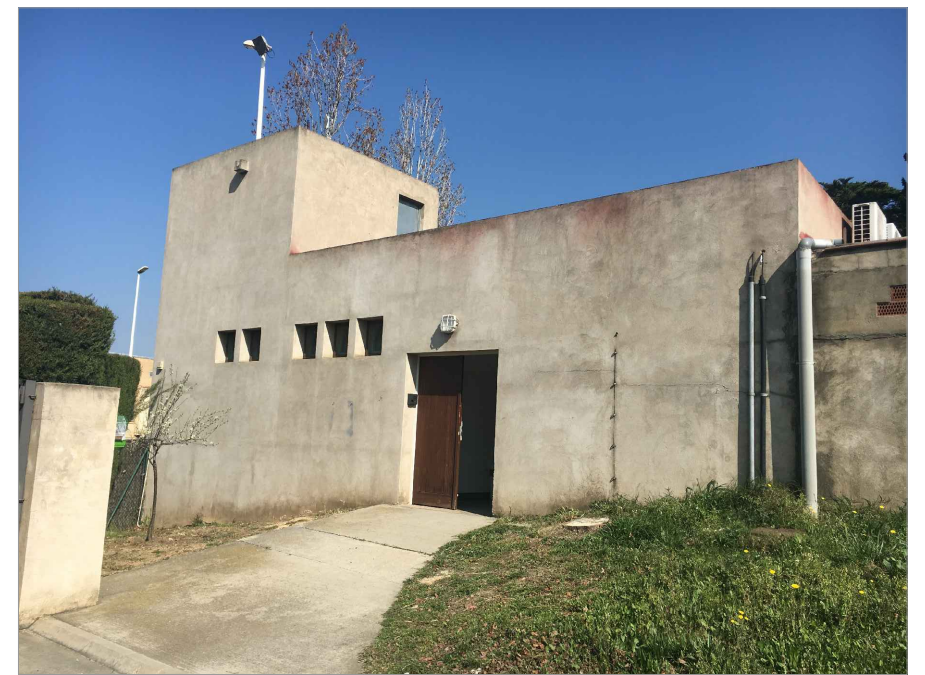
ESTAT ACTUAL FAÇANA SUD
