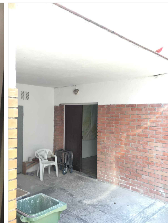
Estat actual del mur 2
