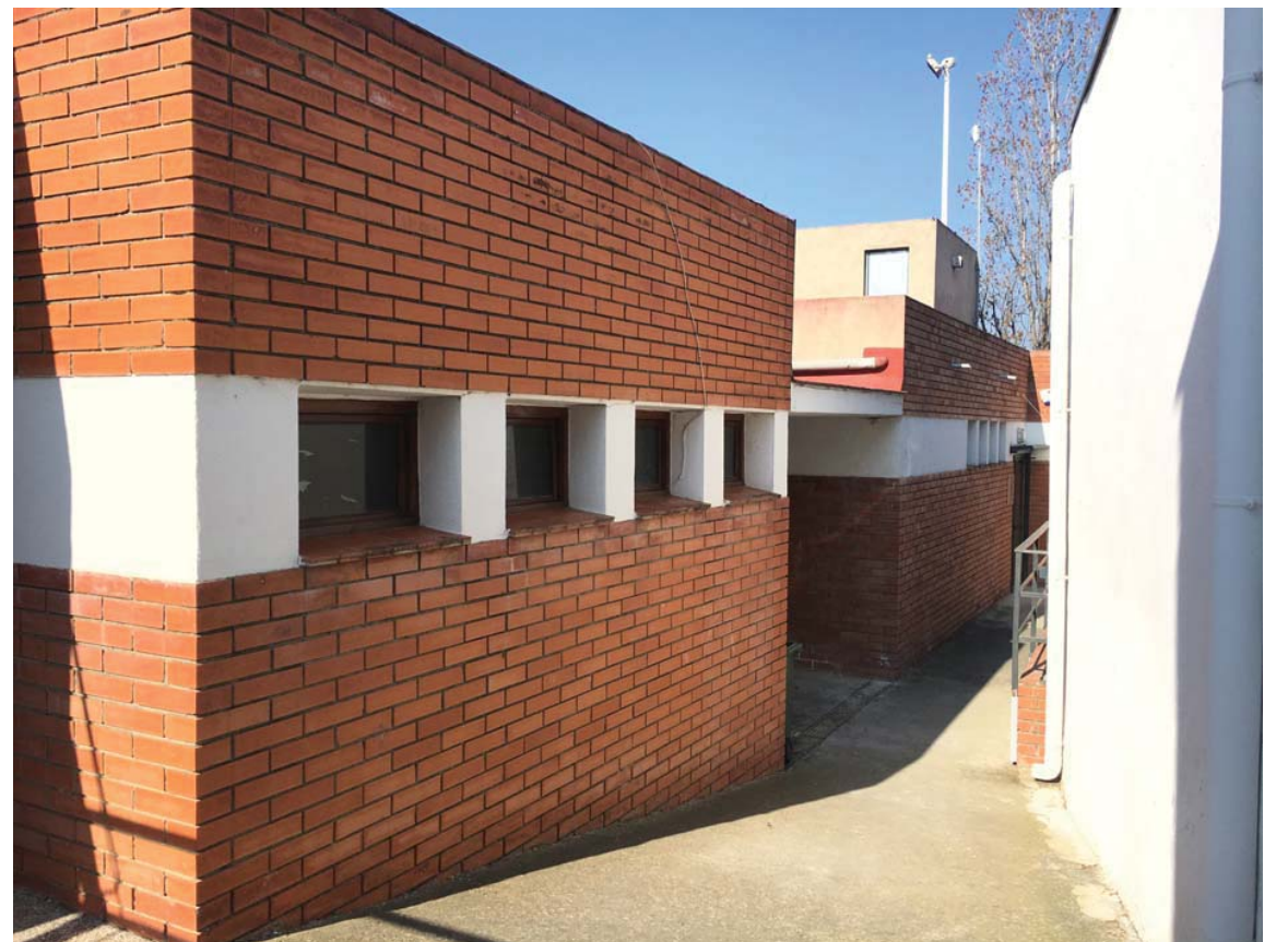
Façana Nord de l'edifici administratiu del Cementiri Municipal de Rubí.
