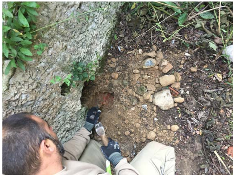
CALA ENTREGA MUR AMB PAVIMENT
