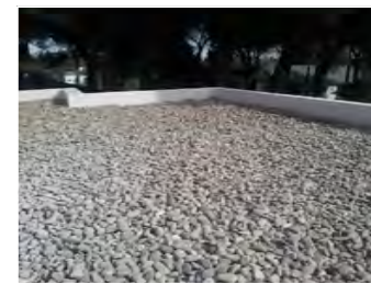
Coberta plana amb acabat de grava
