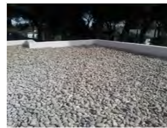
Coberta plana amb acabat de grava
