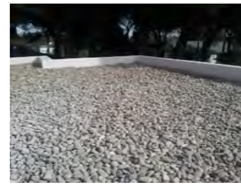
Coberta plana amb acabat de grava
