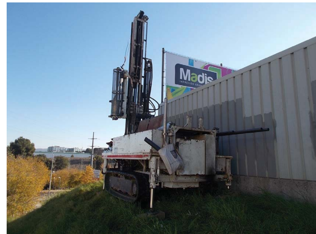
Fotografies 5 i 6. Emplaçament dels sondeigs S2 i S3 tocant el mur
