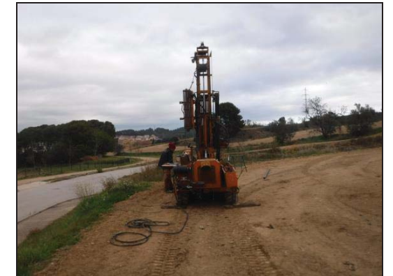
Foto 8: Sondeig S-3, SPT a 1,9 metres.
