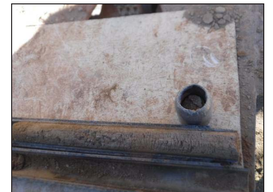
Foto 24: Sondeig S-8, SPT a 2 metres.
