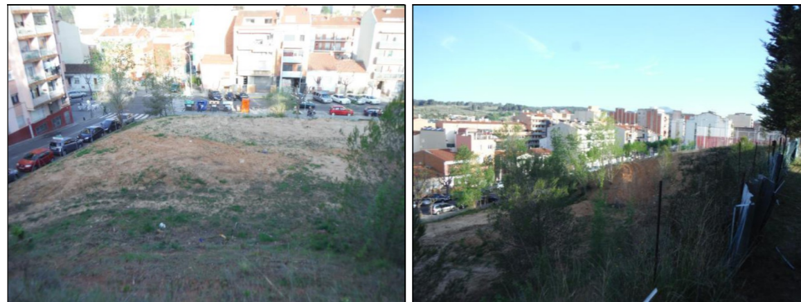
Vista del solar des de la part alta (façana Est).
